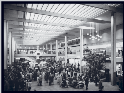
Figura 7, Midtown Plaza interni , fotografia del 1962 (da Central Library of Rochester and Monroe County)
