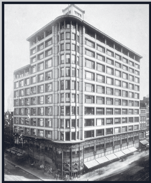
Figura 4, Emporio Carson, Pirie, Scott , Chicago. Esterno dell'edificio. (Da smarthistory.org )
