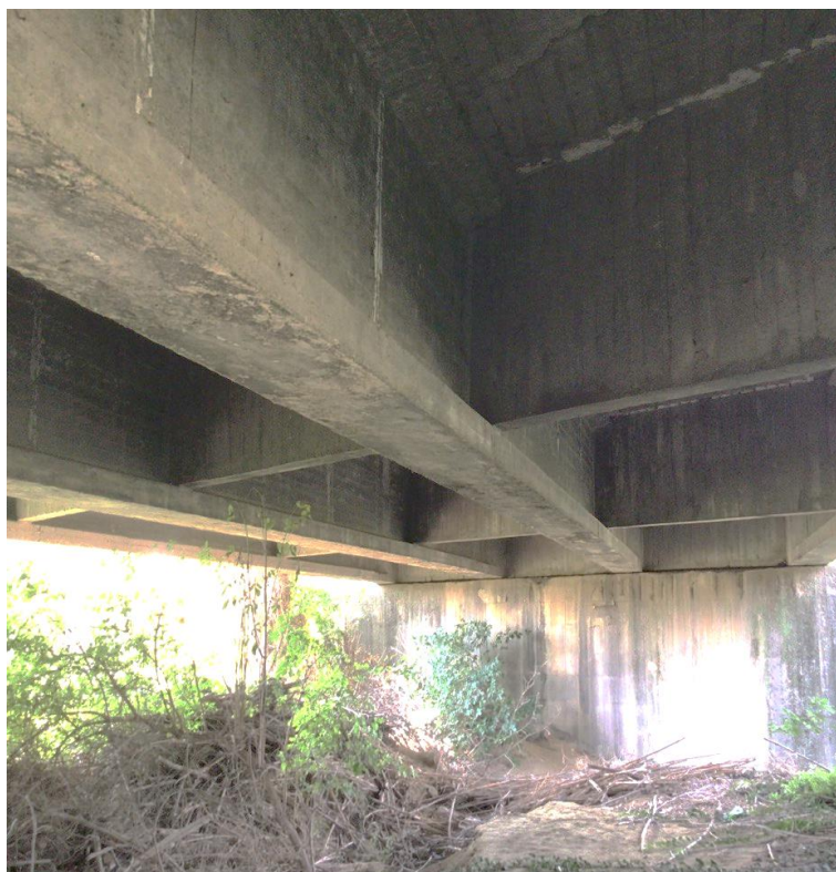
Figura 6 - Impalcato lato Acqui Terme
