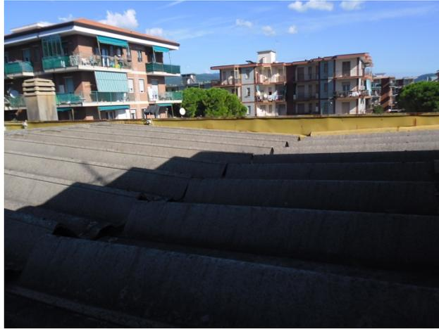
Figura 24. Strato di amianto presente nell'attuale solaio di copertura
