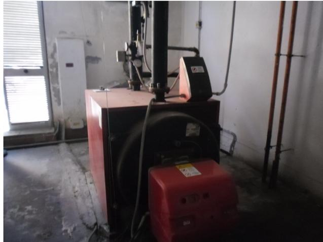
Figura 10. Caldaia a basamento RIELLO 3900.265
