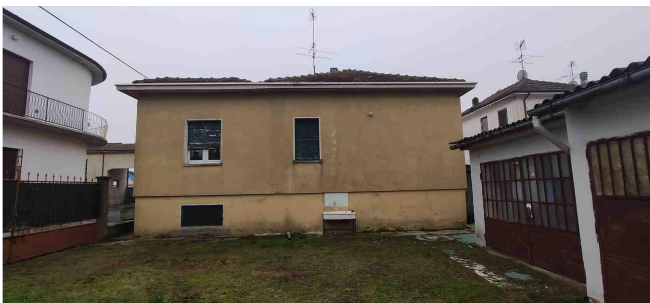
Figura 21 Redazione fotografica stato di fatto
