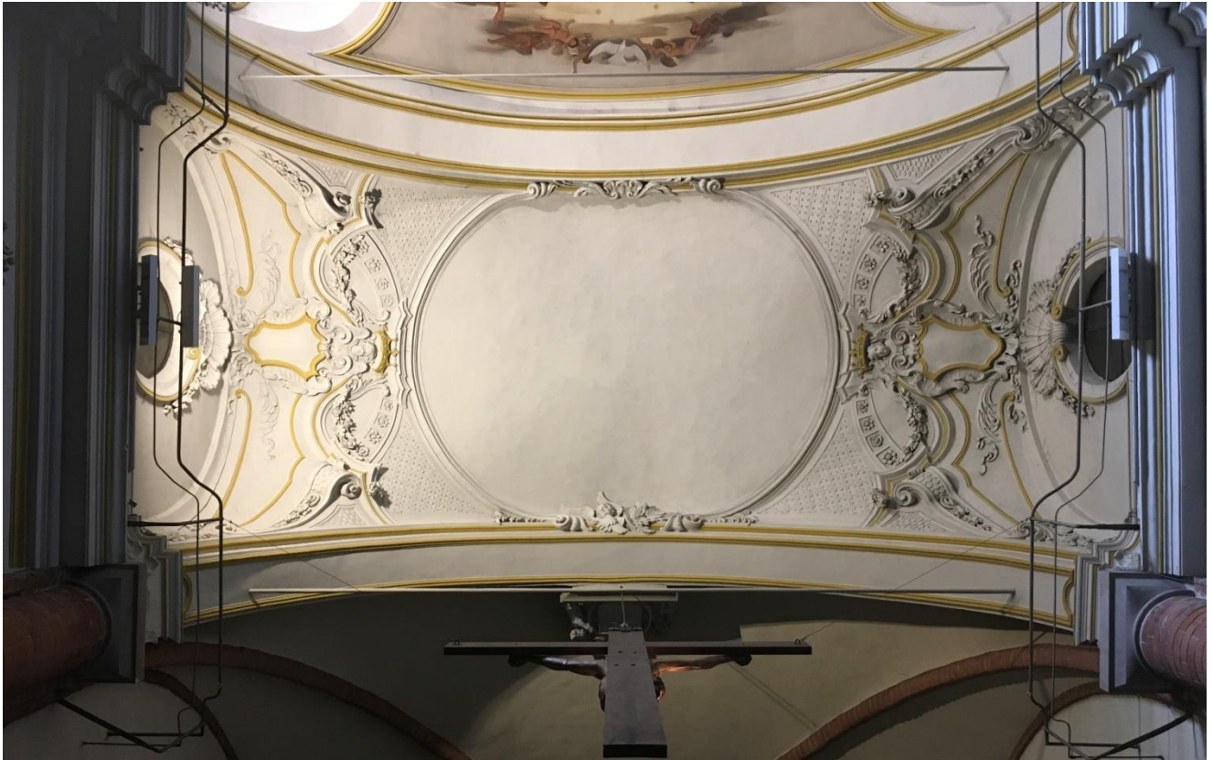
F. 24 – LA VOLTA DEL SANCTA SANCTORUM CON I TIRANTI NELLE ARCADE
