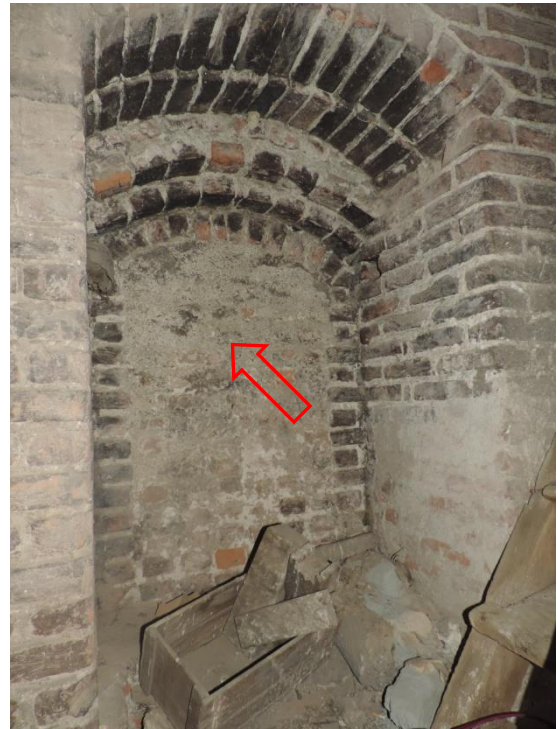
FOTOGRAFIA 31S – L'INTERNO DELLA MONOFORA A NORD - EST
