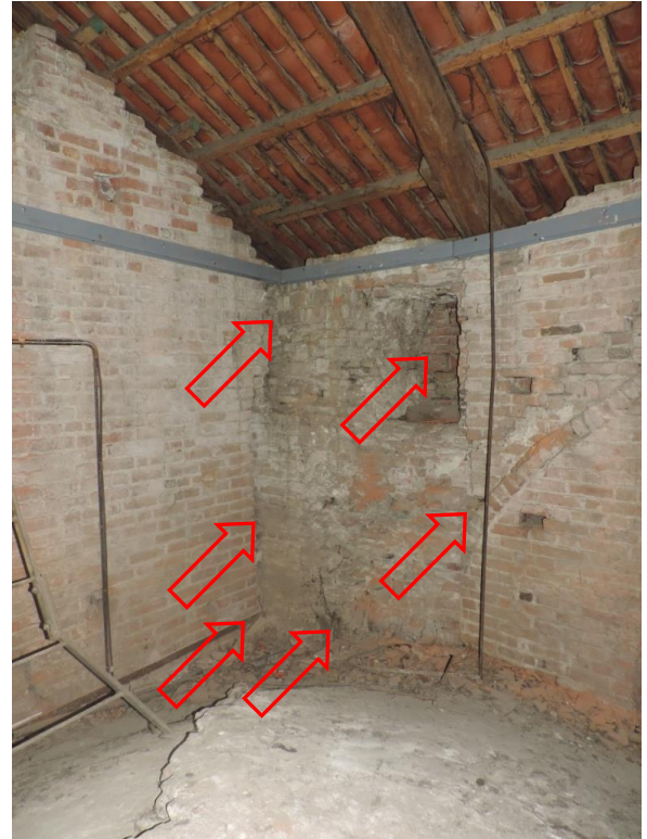
FOTOGRAFIA 6S – IL SECONDO TRATTO DI MURO LUNGO VIA PRINCIPESSA MARIA CLOTILDE DI SAVOIA NELLA DIVISIONE CON N 3
