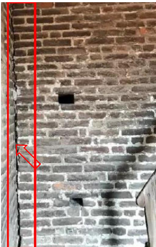
FOTOGRAFIA 28S – L'ANGOLO PRIVO DI CONNESSIONE
