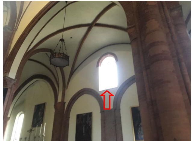
FOTOGRAFIA 115 – LA FINESTRA SULLA TERZA CAMPATA
