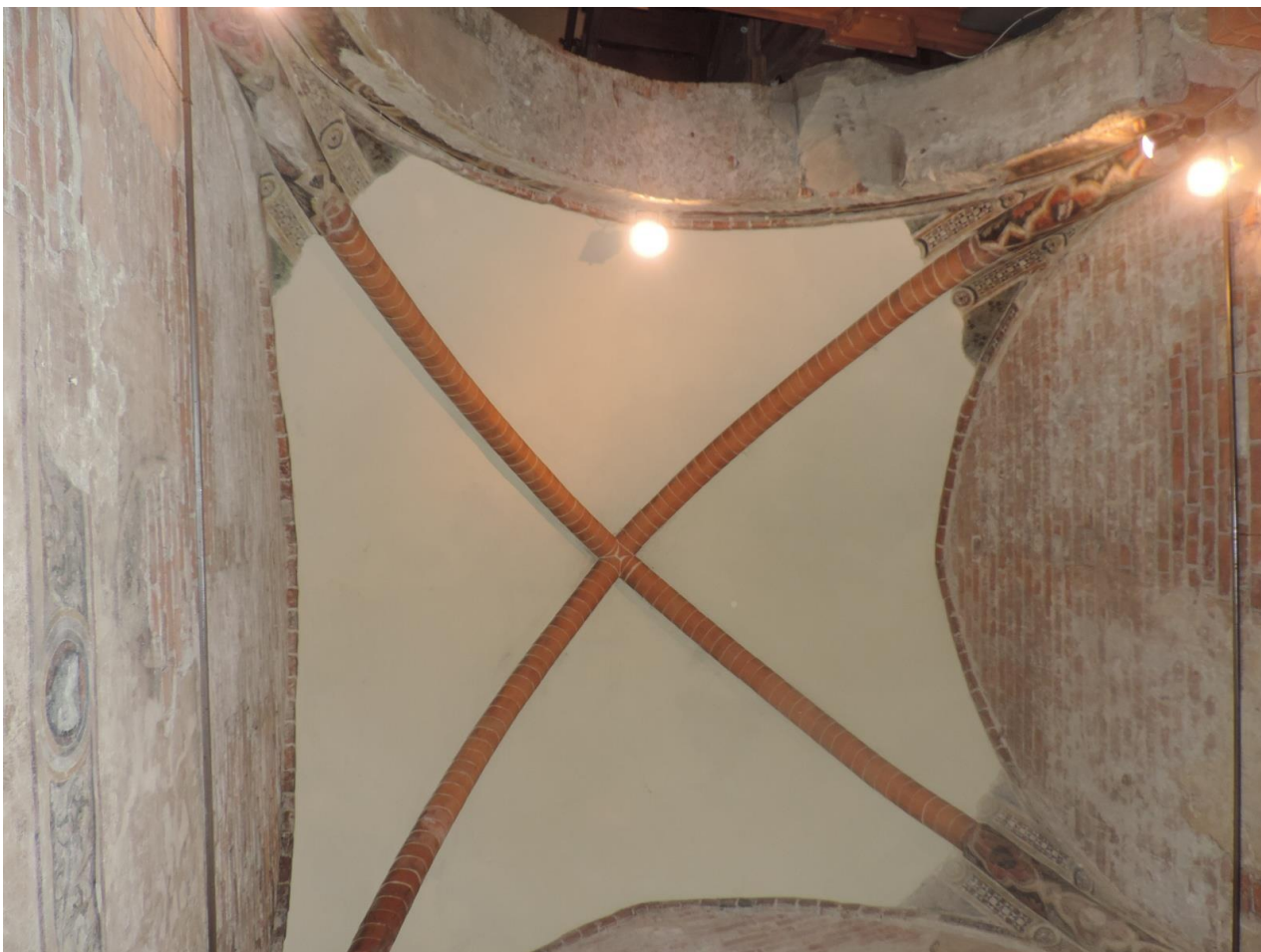
FOTOGRAFIA 77 – LA VOLTA DELLA CAPPELLA DEL BATTISTERO CON I COSTOLONI IN PARTE DECORATI
