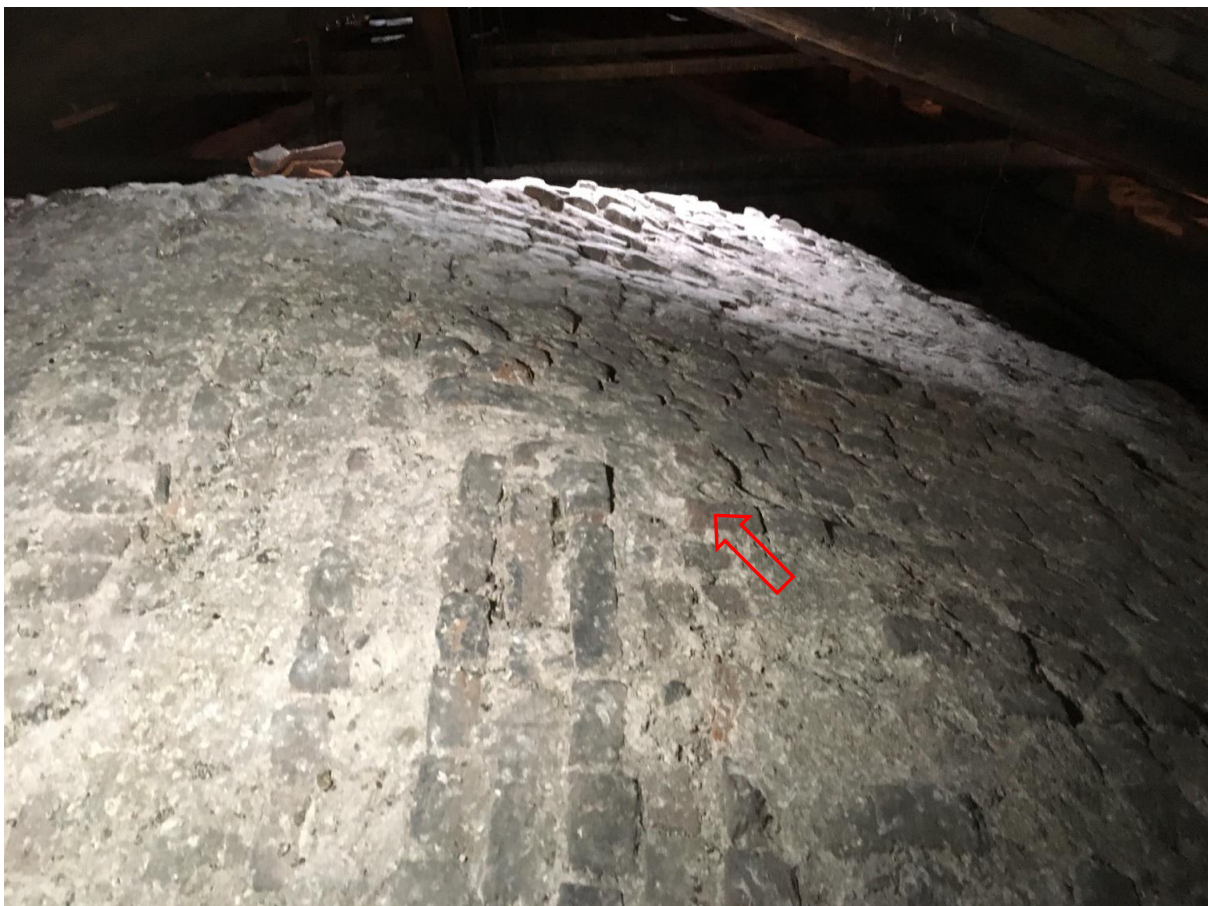
FOTOGRAFIA 42S – LA DISPOSIZIONE DEI MATTONI SULLA VOLTA IN C 3
