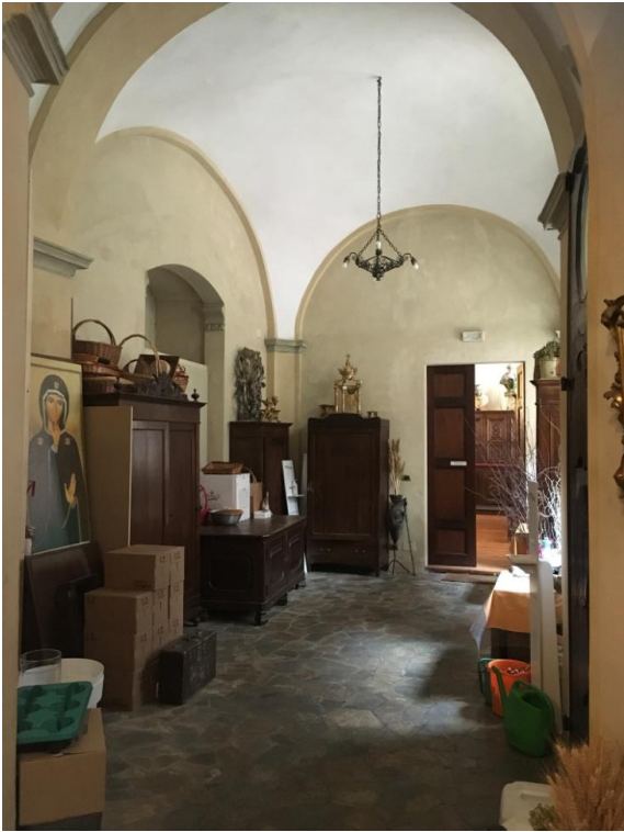
FOTOGRAFIA 4 - PRIMA PARTE DISIMPEGNO USCITA SACRESTIA VOLTATA A VELA
