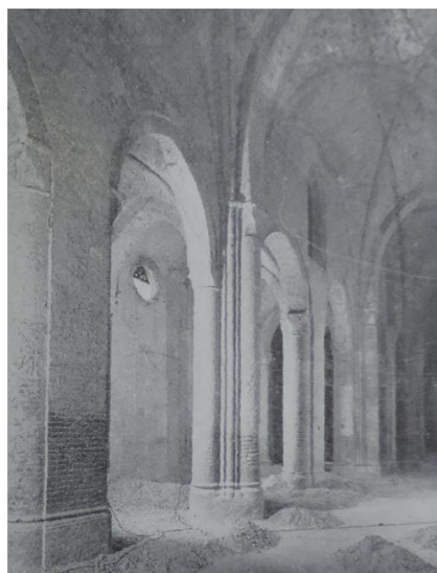
F. 28 – LA TERZA E QUARTA NAVATA AD INIZIO INTERVENTO
