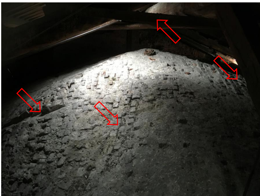
FOTOGRAFIA 37S – LE IMPRONTE DI PRECEDENTI APPOGGI DIRETTI, LA COLLOCAZIONE DEI MATTONI LUNGO IL LATO DI PUNTA E LA SOTTOCATENA
