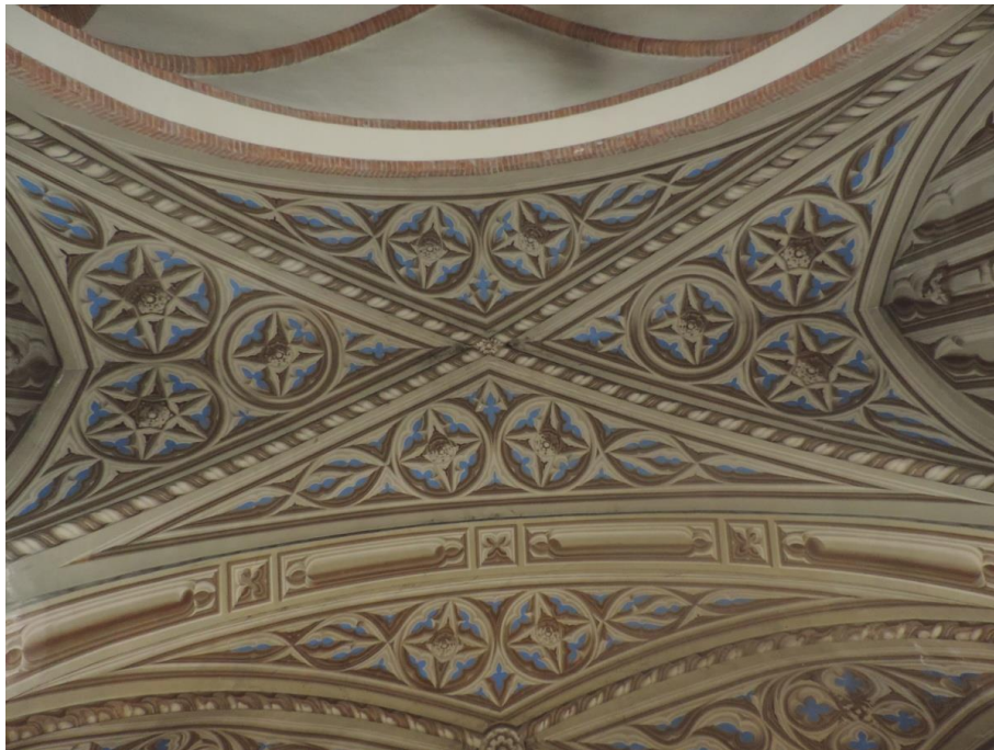
FOTOGRAFIA 52 – LA PRIMA PARTE DELLA VOLTA DELLA CAPPELLA DEL SANTISSIMO SACRAMENTO
