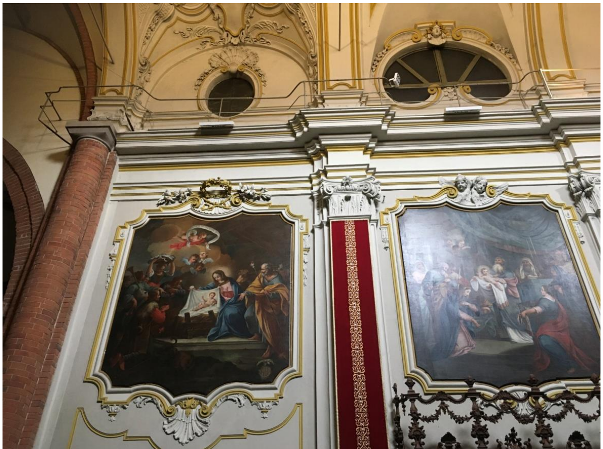
FOTOGRAFIA 23 – PARTICOLARI DELLE FINESTRE E INNESTO VOLTA
