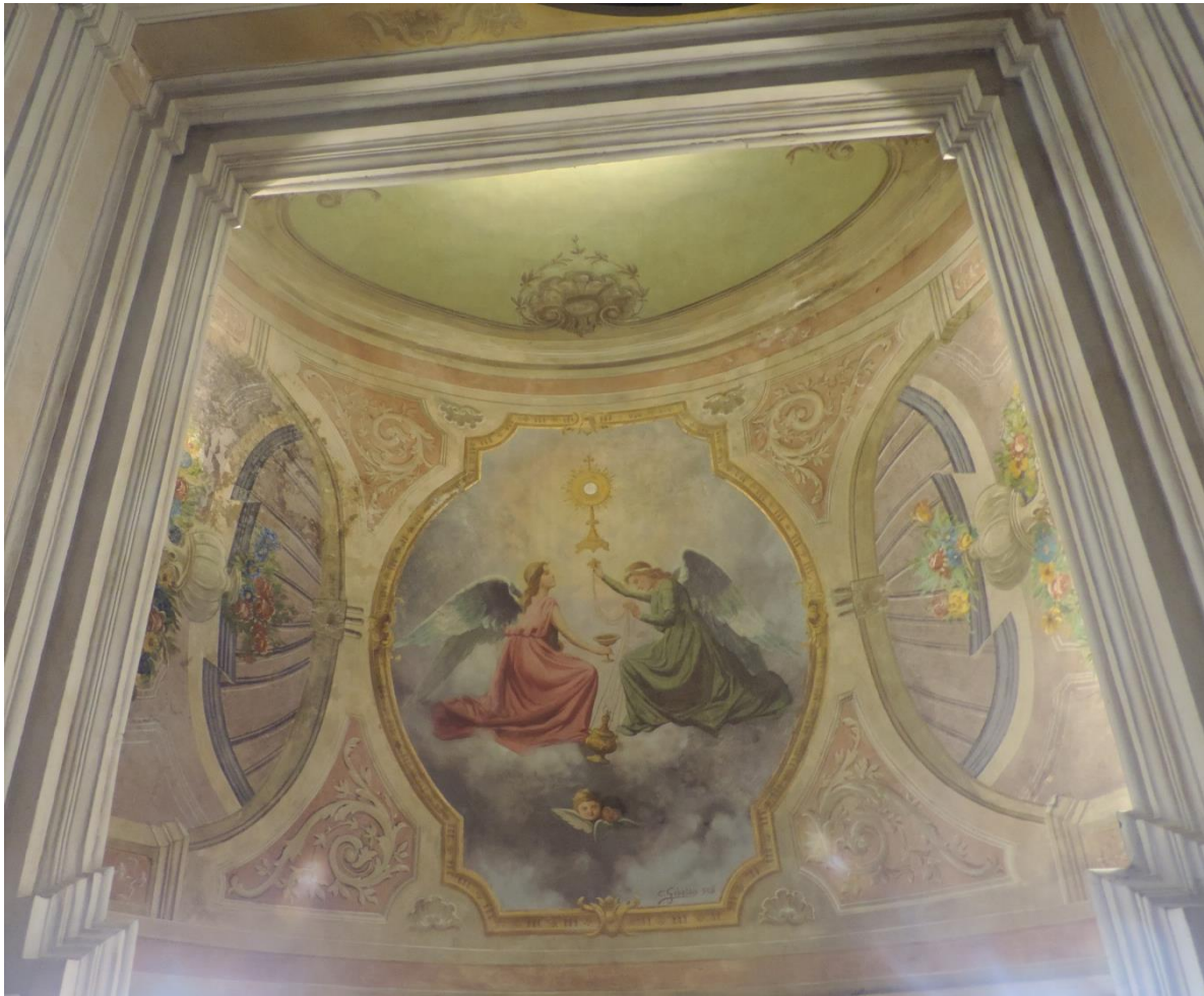
F. 39 – LA PARTE DI VOLTA ALL'INGRESSO DELLA CAPPELLA
