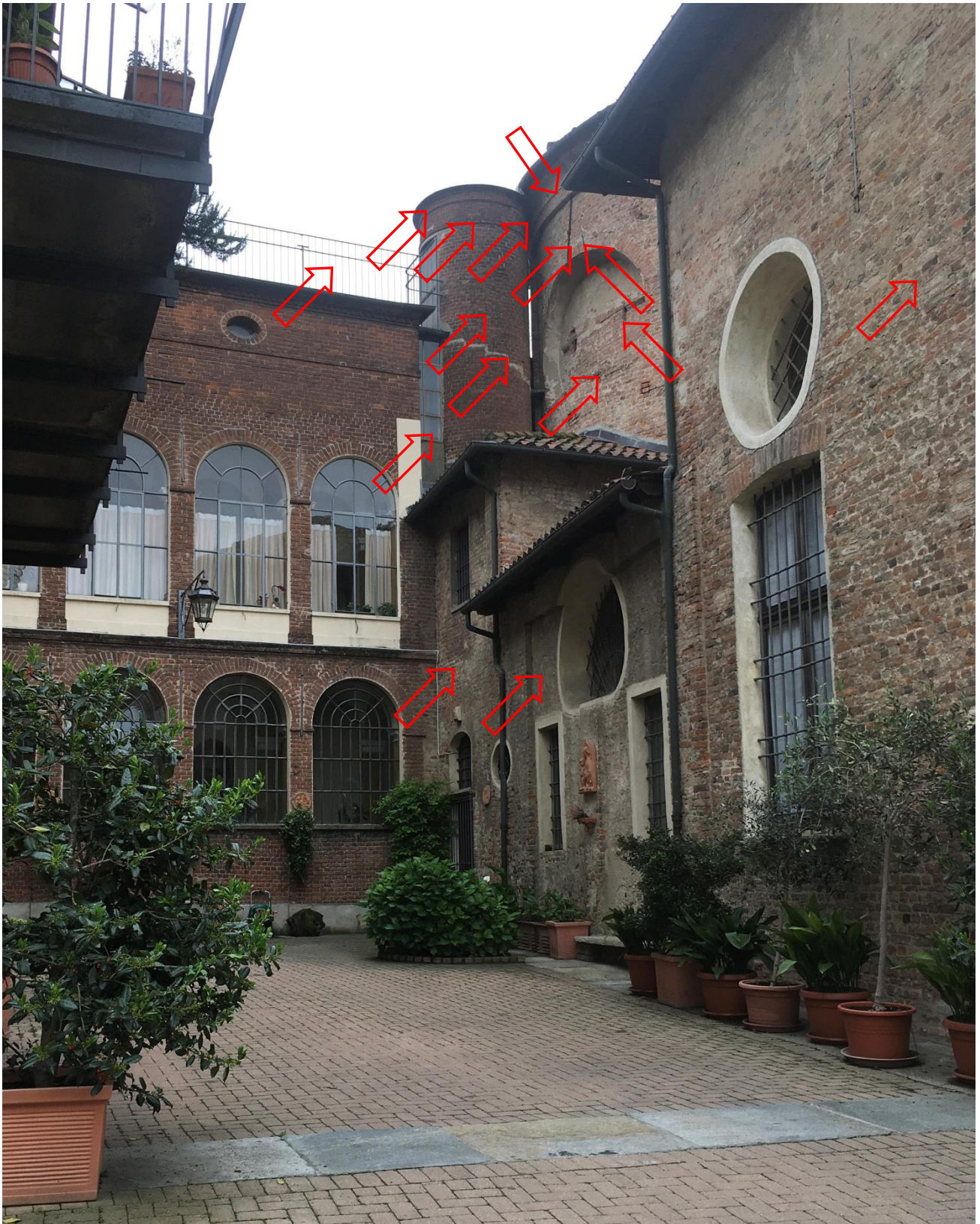
FOTOGRAFIA 163 – I FABBRICATI SUL LATO DESTRO DEL CORTILE
