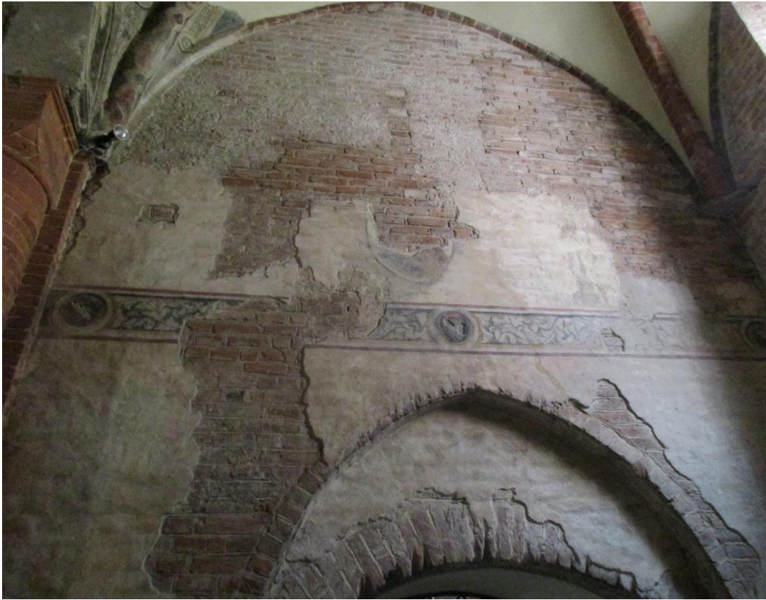
FOTOGRAFIA 78 – LA MURATURA DEL BATTISTERO SUL LATO INTERNO SOPRA L'INGRESSO
