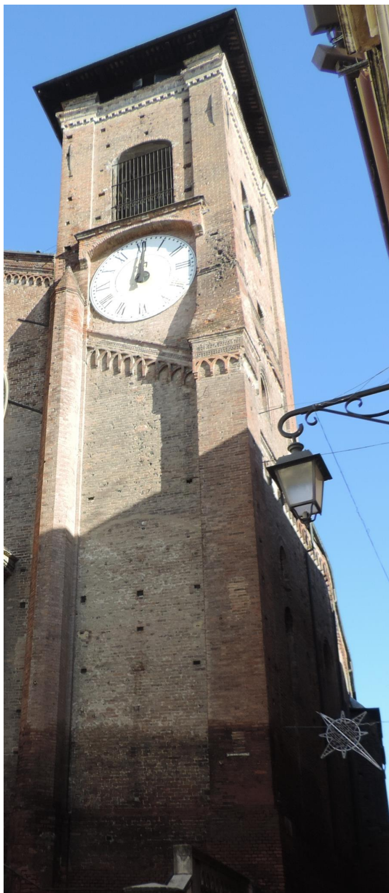
FOTOGRAFIA 133 – LA PARTE DELLA FACCIATA COLLOCATA A DESTRA E LA TORRE CAMPANARIA
