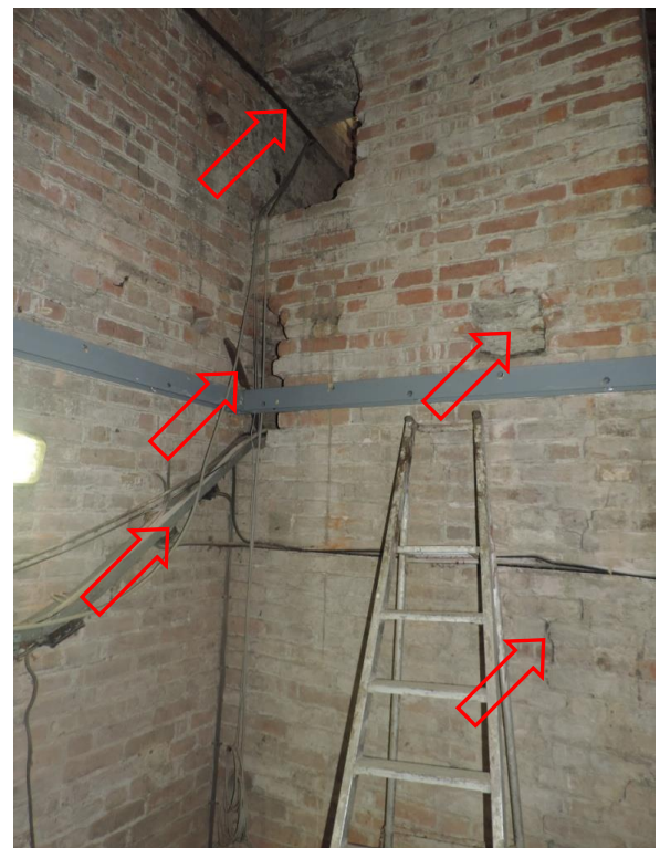
FOTOGRAFIA 8S – L'ANGOLO TRA IL MURO CHE DIVIDE N 2 DA N 3 E QUELLO CHE DIVIDE LA NAVATA LATERALE DA QUELLA CENTRALE
