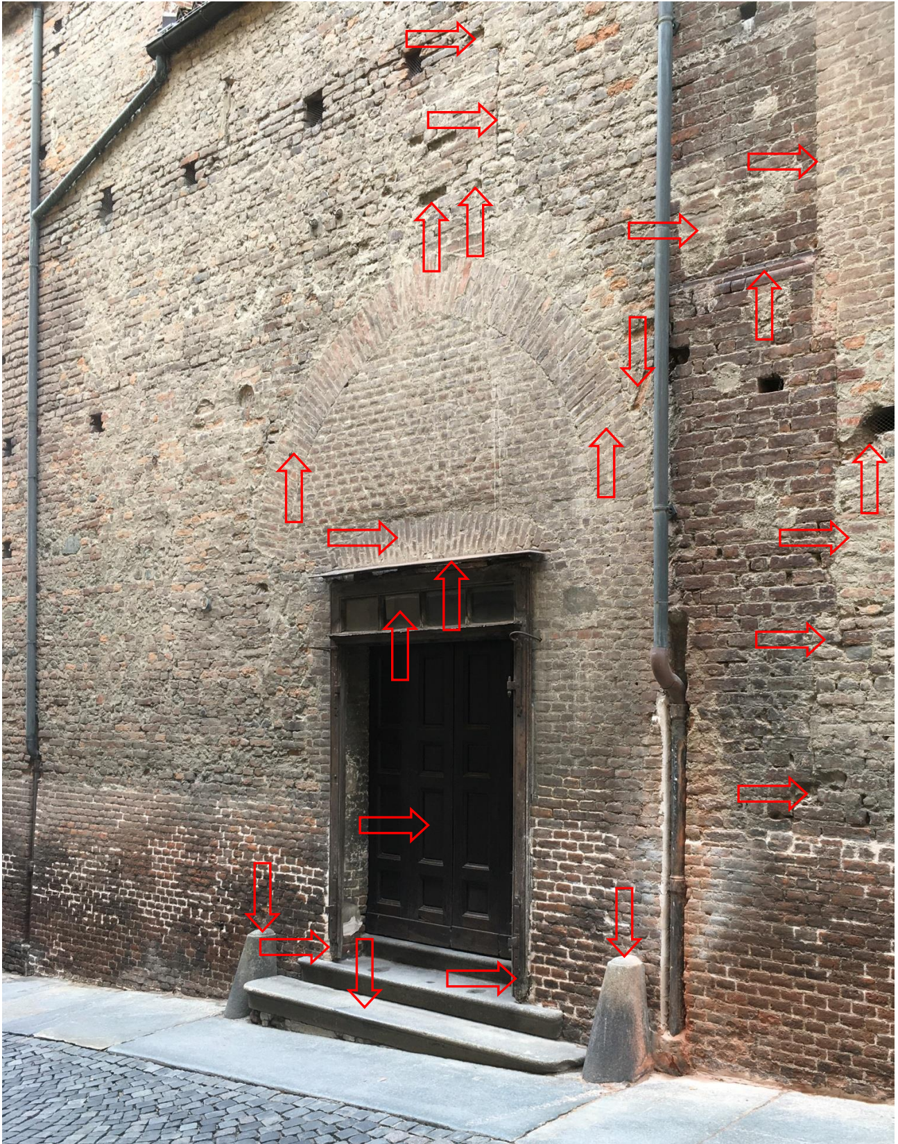
FOTOGRAFIA 156 – L'INGRESSO LATERALE E IL SETTORE LUNGO VIA PRINCIPESSA MARIA CLOTILDE
