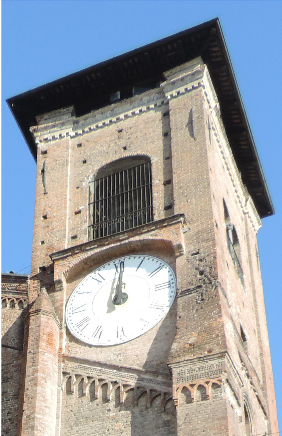
FOTOGRAFIA 134 – LA PARTE CONCLUSIVA IN FACCIATA DELLA TORRE CAMPANARIA
