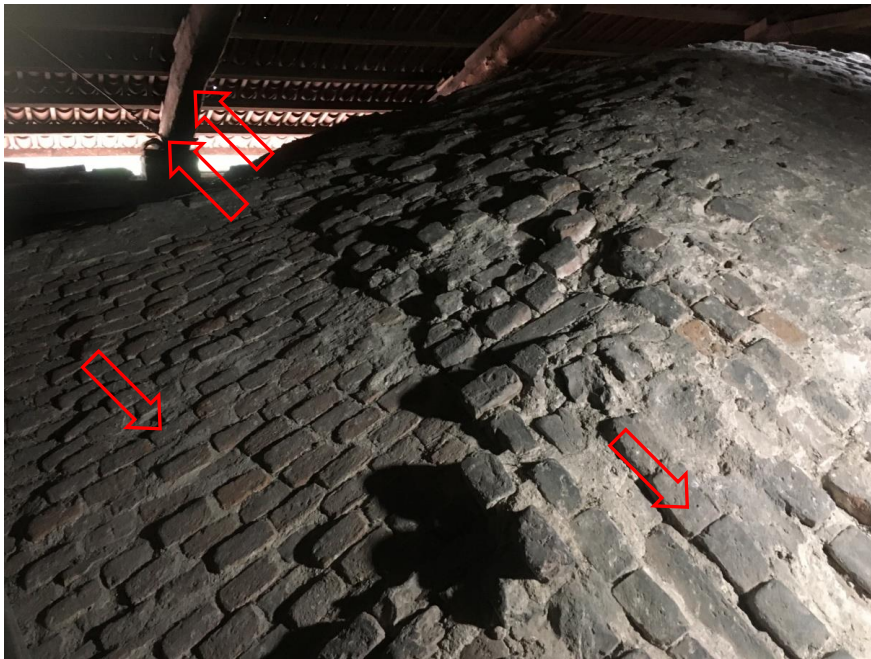
FOTOGRAFIA 36S – LA PARTE DELLA VOLTA RICOSTRUITA E LA COLLOCAZIONE DEI MATTONI LUNGO IL LATO DI PUNTA
