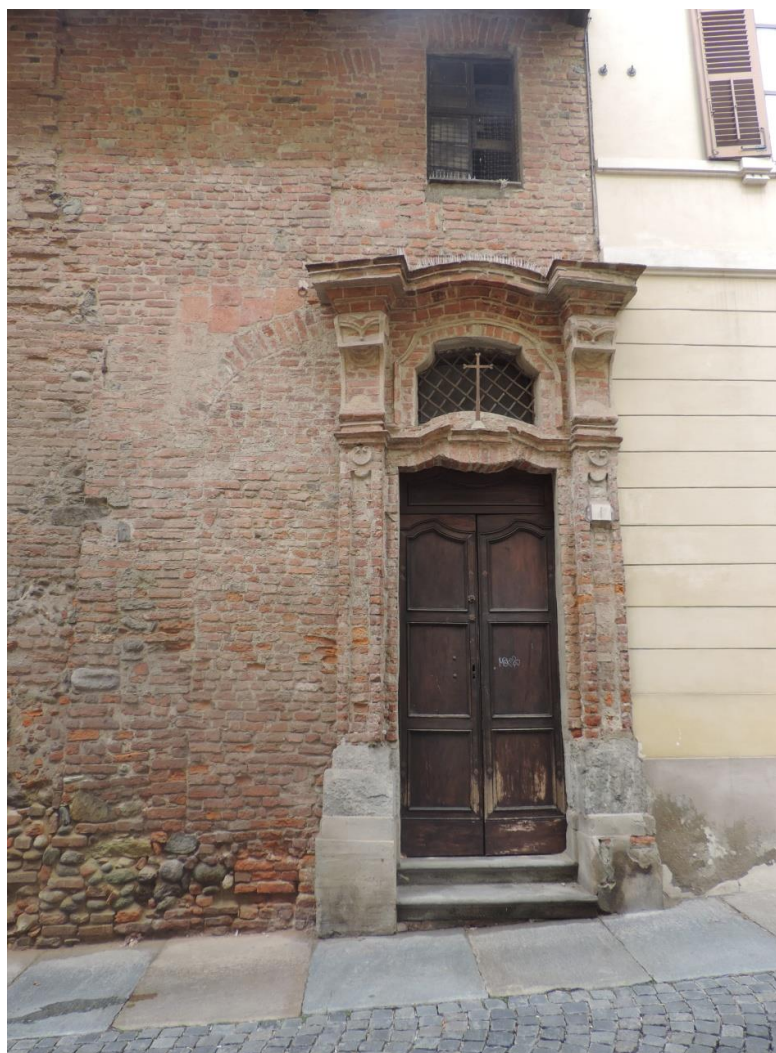
FOTOGRAFIA 140 – LA VECCHIA CASA CANONICA CON IL PORTALE, LA PARTE SUPERIORE CON LA CROCE E LA PORTA
