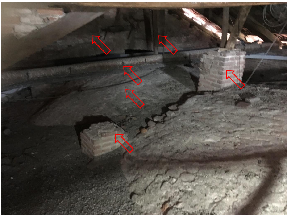
FOTOGRAFIA 50S – LA ZONA DEGLI APPOGGI CENTRALE E LATERALE, LA VOLTA, LA CAPRIATA E LA MURATURA CONCLUSIVA SU ARCO DI SCARICO
