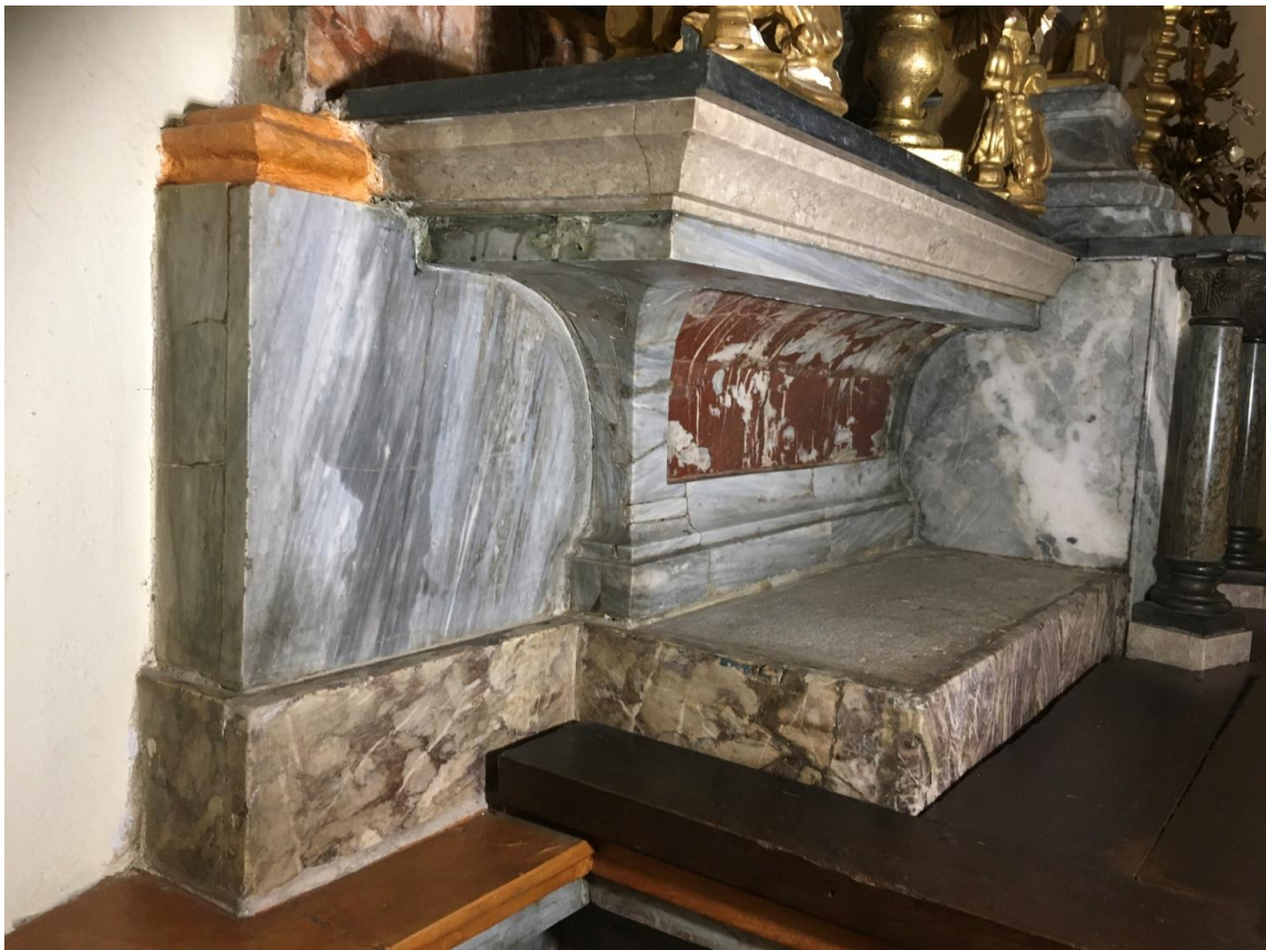
FOTOGRAFIA 40 – LATO SINISTRO DELL'ALTARE
