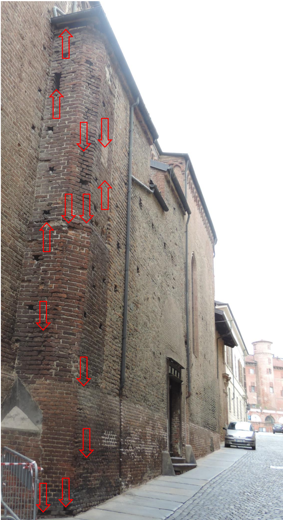
FOTOGRAFIA 154 – IL PILASTRO ANGOLARE E L'ALLARGAMENTO LATERALE
