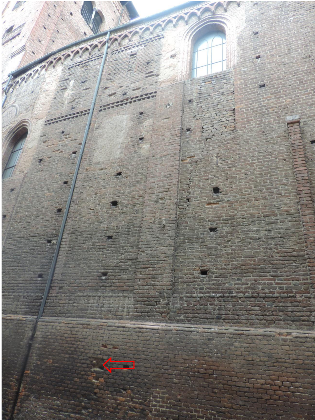
FOTOGRAFIA 151 – IL PILASTRO CENTRALE E I SETTORI DI MURATURA LATERALI
