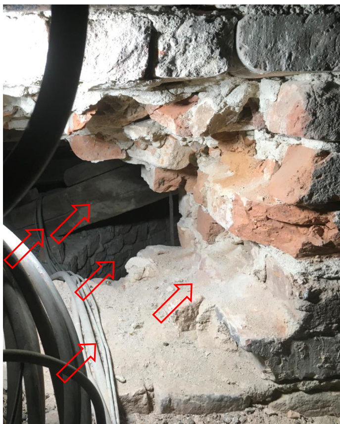
FOTOGRAFIA 26S – LA PARTE INIZIALE DEL SOTTOTETTO IN N 7
