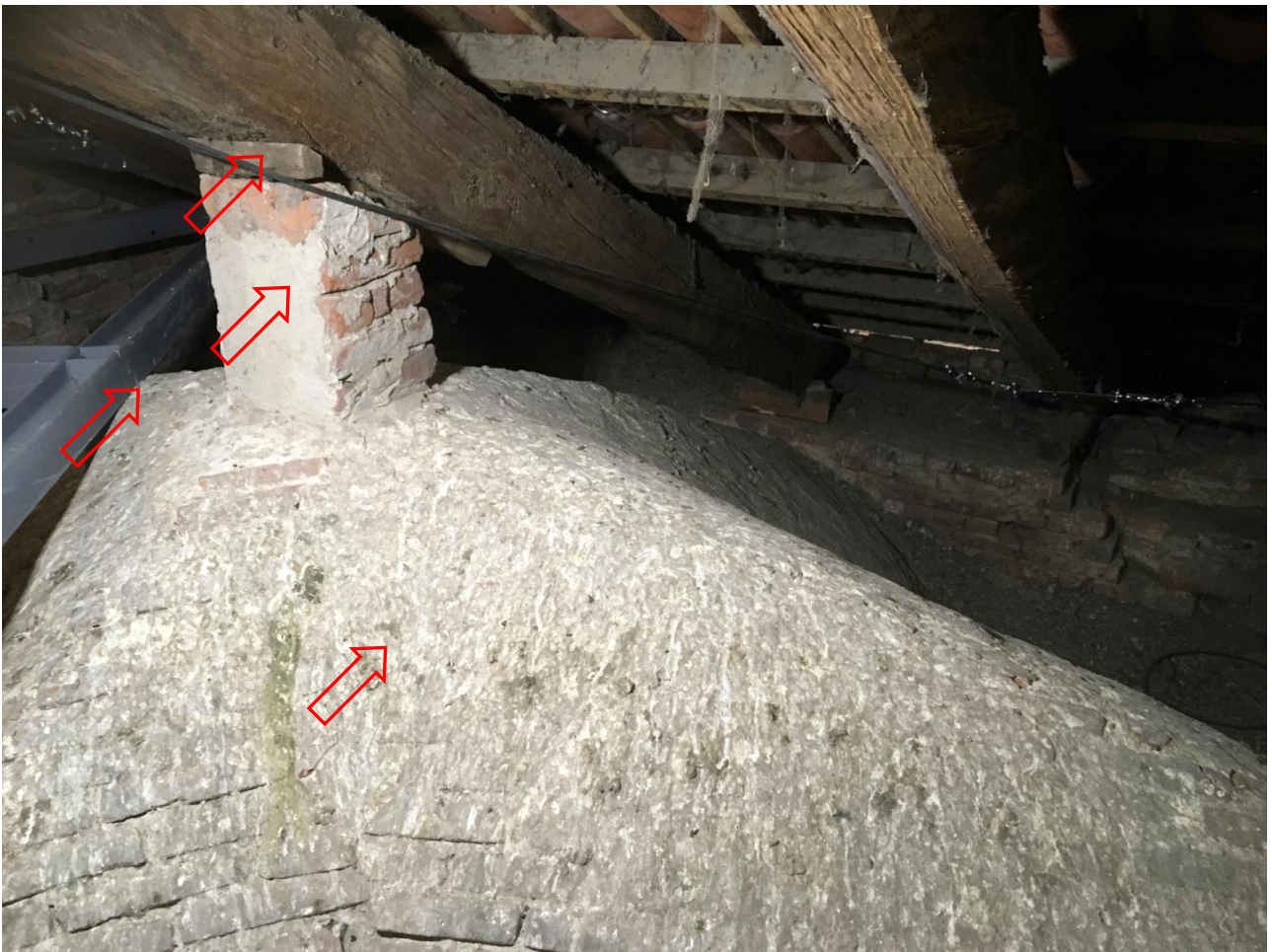
FOTOGRAFIA 22S – L'ESTRADOSSO DELLA VOLTA NEOGOTICA CON AL CENTRO IL PILASTRINO PER L'APPOGGIO DEL FALSO PUNTONE
