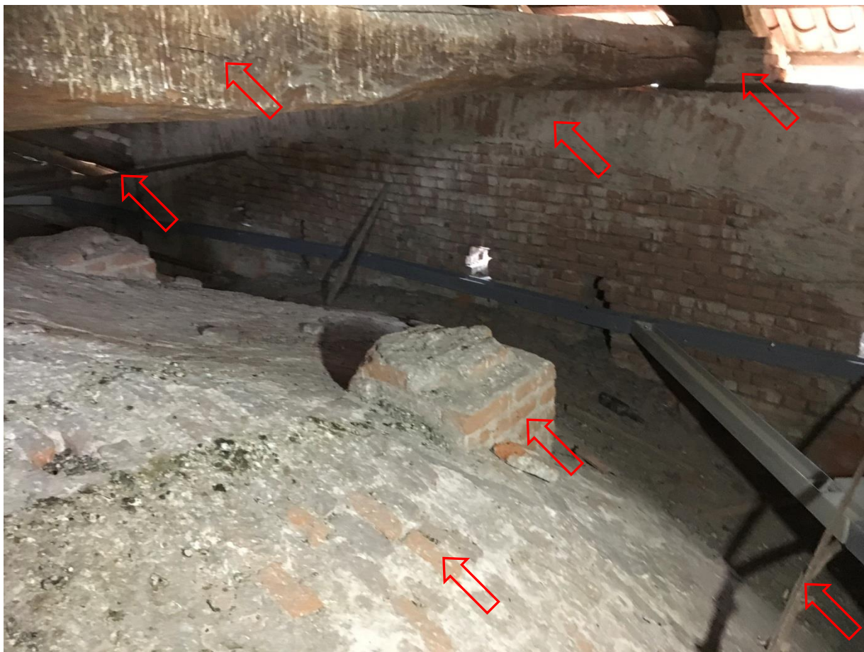
FOTOGRAFIA 45S – IL LATO INTERNO VERSO IL COMUNE DELLA CAMPATA C 4 CON L'ARCO RIBASSATO, LA VOLTA, GLI APPOGGI, LA CATENA DI UNA CAPRIATA E LE CHIAVI A BRAGA
