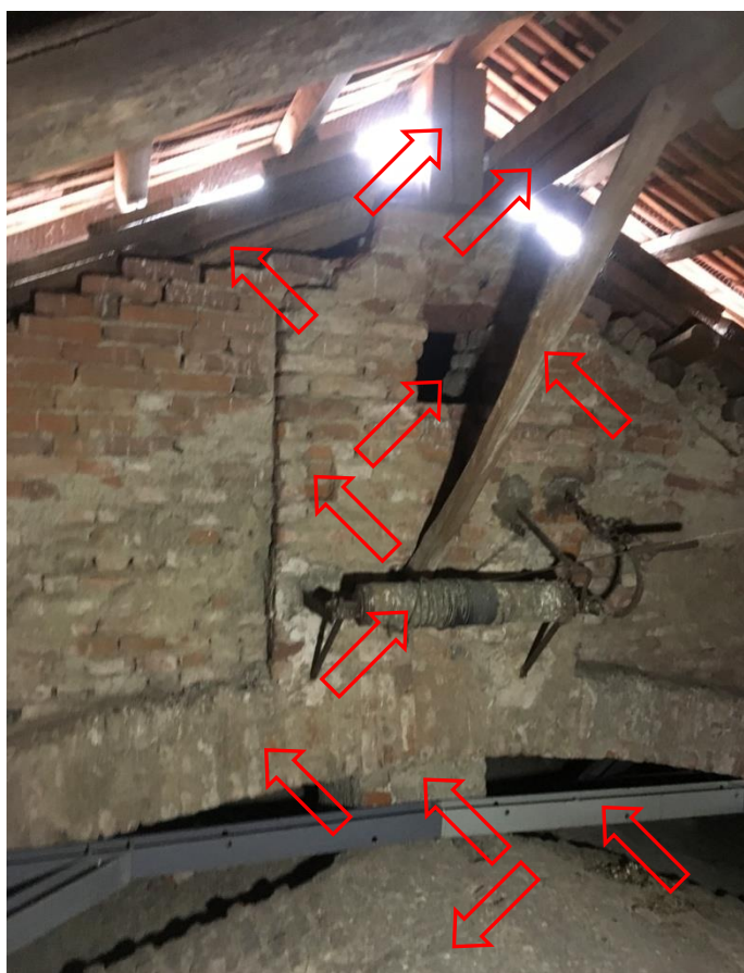
FOTOGRAFIA 52S – LA VOLTA, IL CORDOLO, IL PILASTRINO CENTRALE, L'ARCO DI SCARICO, IL RINFORZO CON APERTURA, IL SOLLEVATORE A TAMBURO, LA SAETTA E I SUPERIORI APPOGGI
