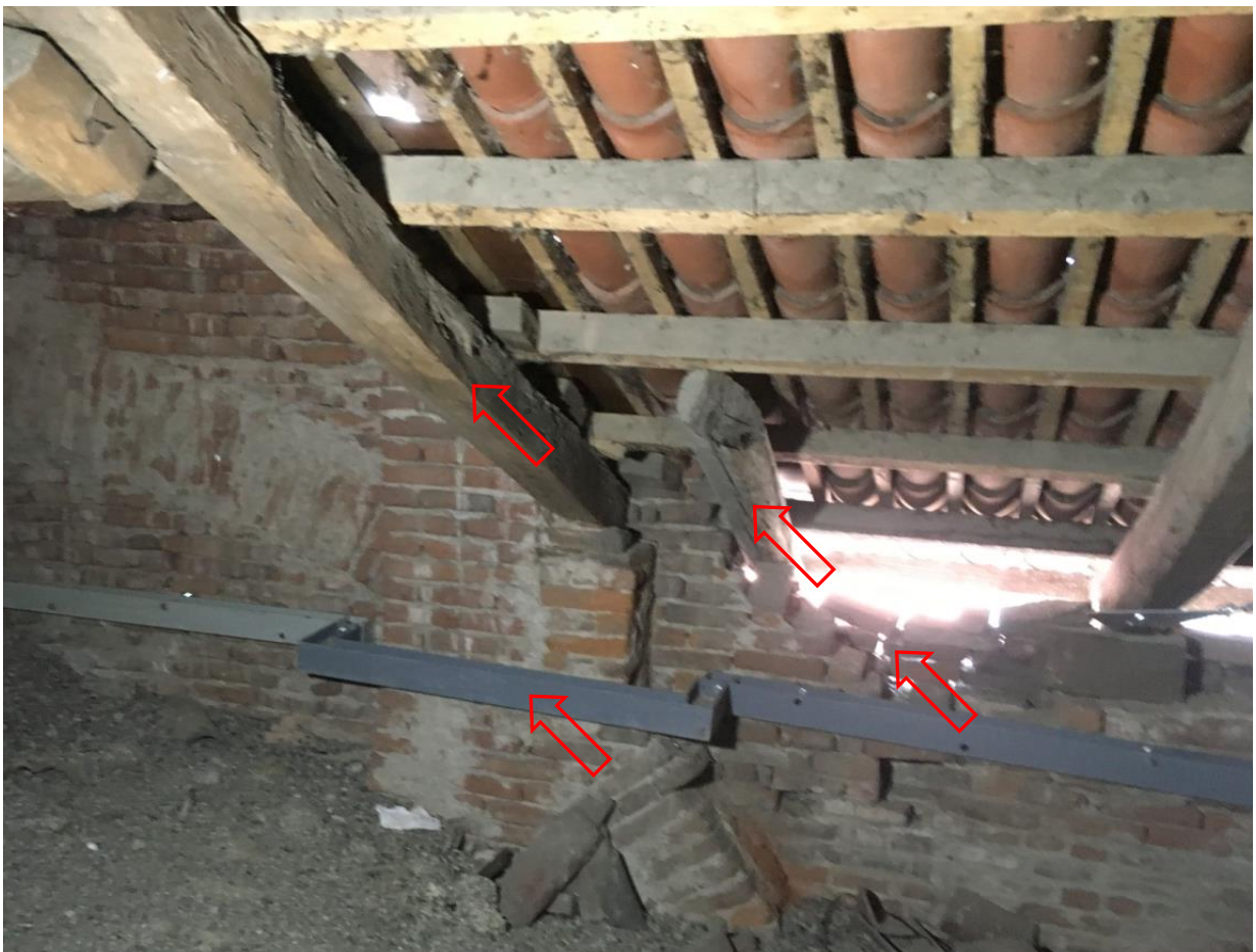
FOTOGRAFIA 48S – LA PARTE ROVINATA DI UN FIANCO LATERALE CON IL PASSAFUORI E IL CORDOLO
