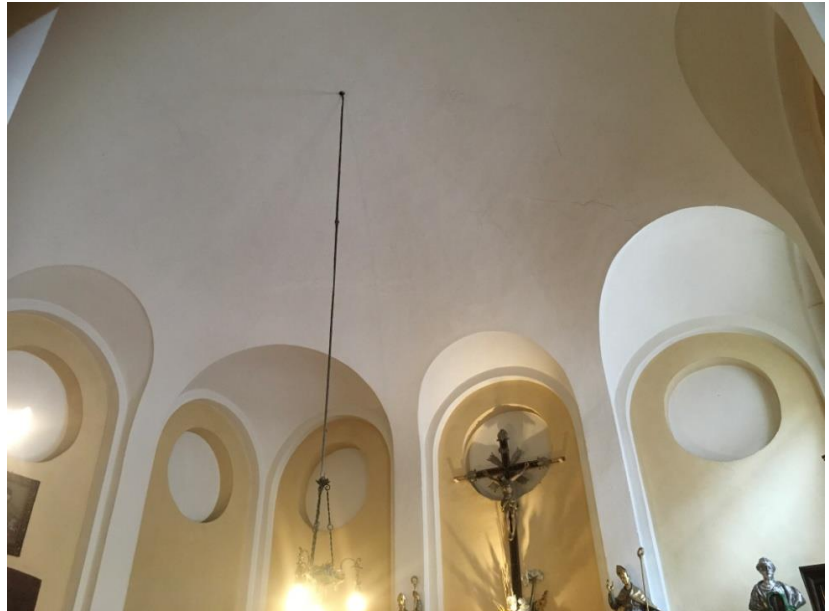
FOTOGRAFIA 3 – INTERNO SACRESTIA – LA VOLTA A CALOTTA SFERICA
