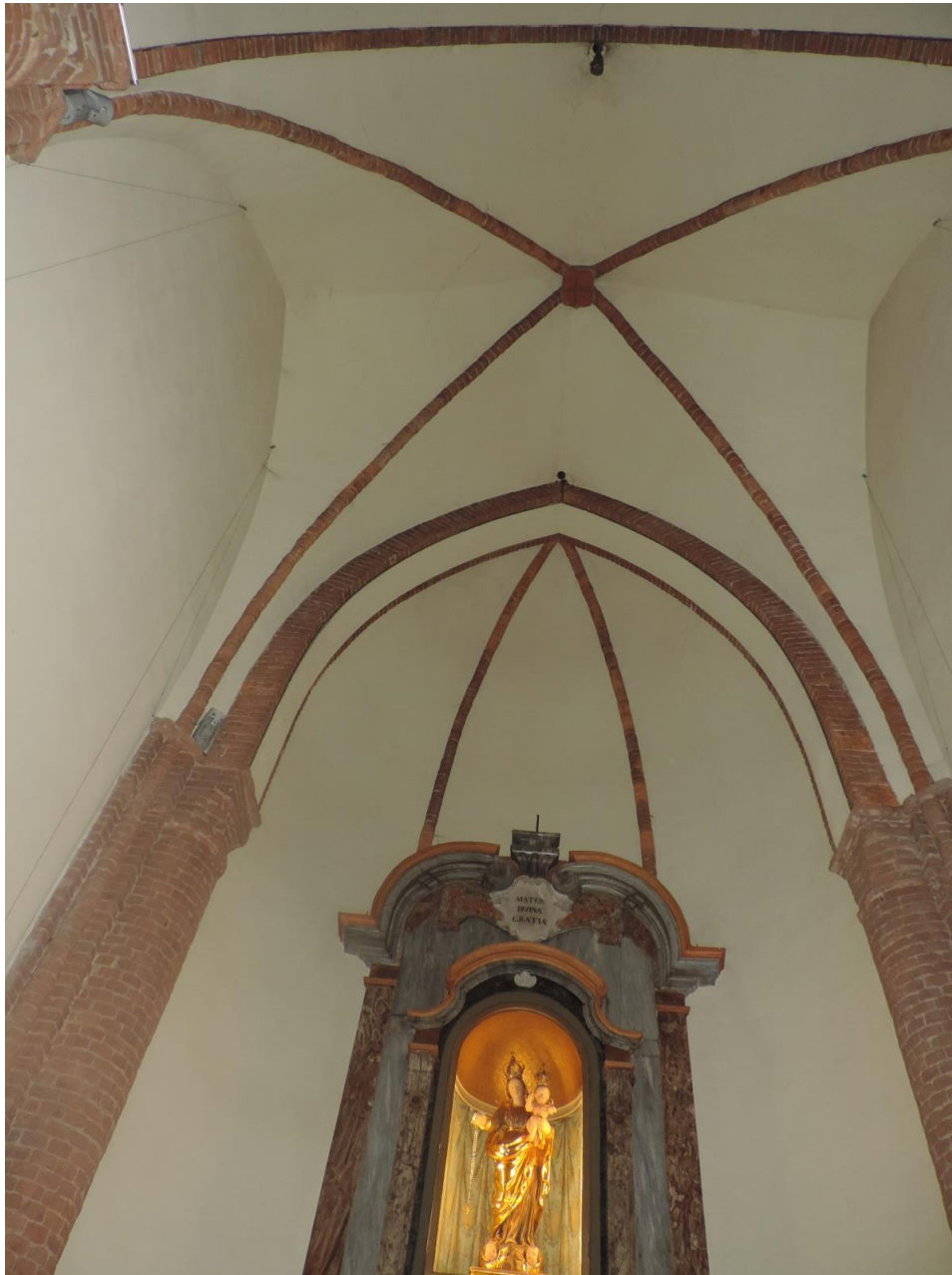
FOTOGRAFIA 39 – LA VOLTA DELLA SECONDA ABSIDE LATERALE
