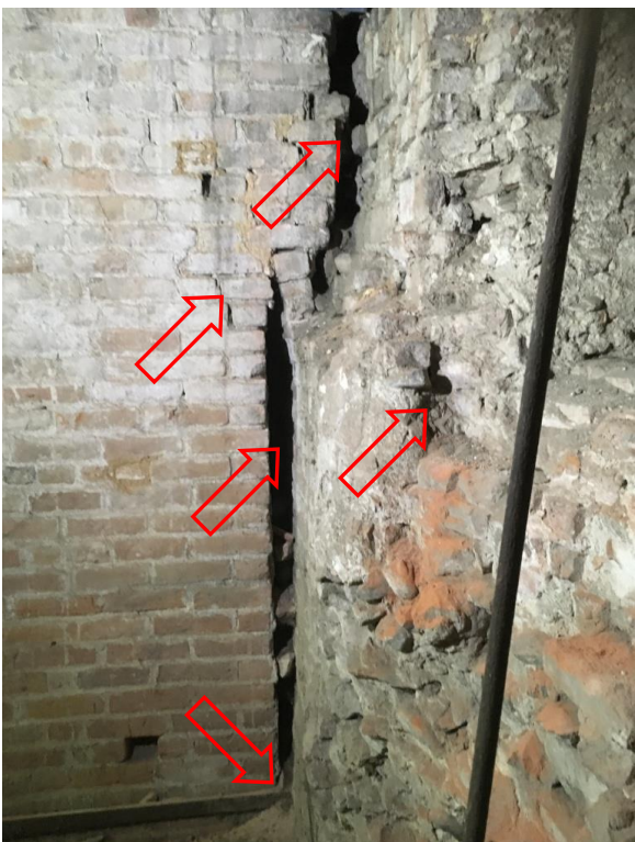
FOTOGRAFIA 7S – LA FORTE APERTURA PER MANCATA CONNESSIONE D'ANGOLO CON LA LAMA PER TIRANTE PIEGATA
