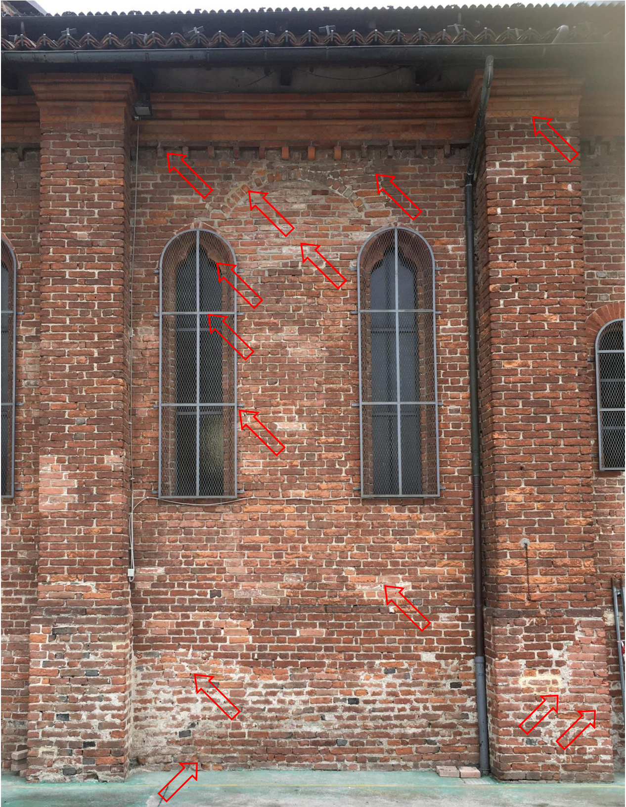
FOTOGRAFIA 180 – LA PARTE ESTERNA DI MURATURA CORRISPONDENTE AL PRIMO TRATTO DELLA CAMPATA CONCLUSIVA DELLA QUARTA NAVATA
