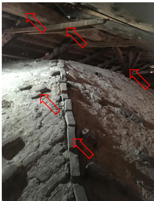
FOTOGRAFIA 40S – IL COLMO, LE TRAVERSE DI SOTTOCATENA, LA CAPRIATA DI FINE CAMPATA E LA SUCCESSIVA VOLTA IN C 2
