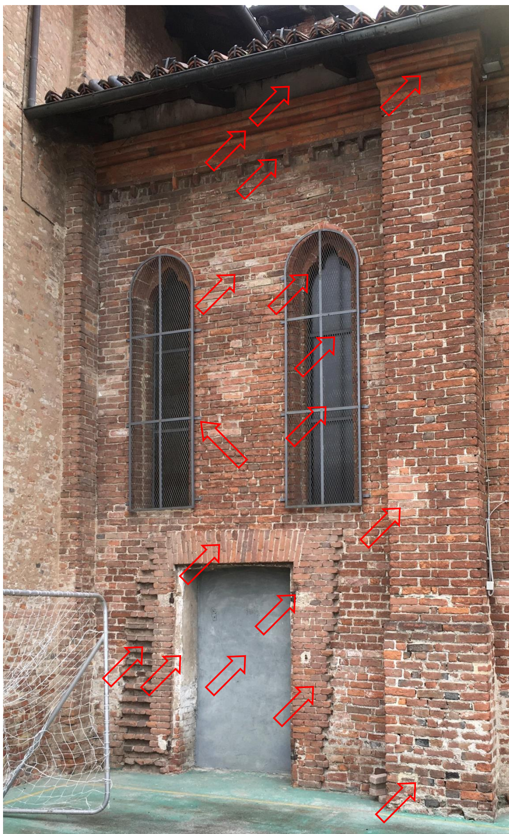
FOTOGRAFIA 179 – LA PARTE ESTERNA DI MURATURA CORRISPONDENTE AL SECONDO TRATTO DELLA CAMPATA CONCLUSIVA DELLA QUARTA NAVATA
