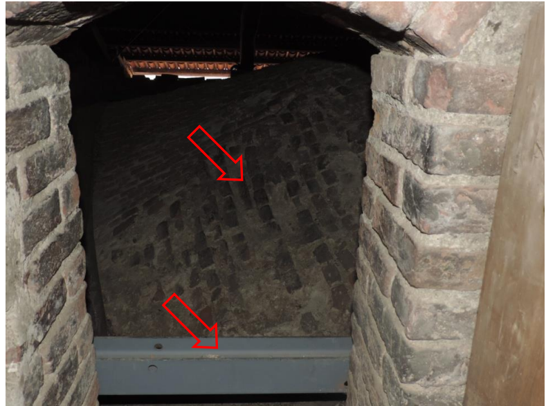
FOTOGRAFIA 35S – L'INGRESSO AL SOTTOTETTO DELLA NAVATA CENTRALE
