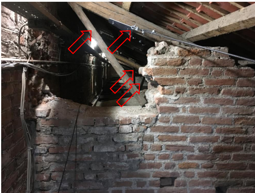
FOTOGRAFIA 15S – IL PUNTONE TRA N 3 E N 4 E LA CONTROVENTATURA
