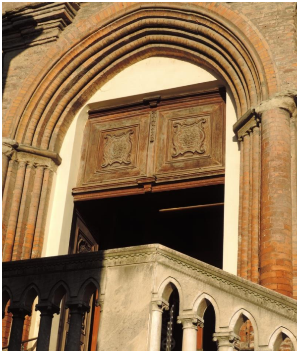
FOTOGRAFIA 120 – IL PORTALE E PARTE DELLE COLONNINE DELLO SCALONE
