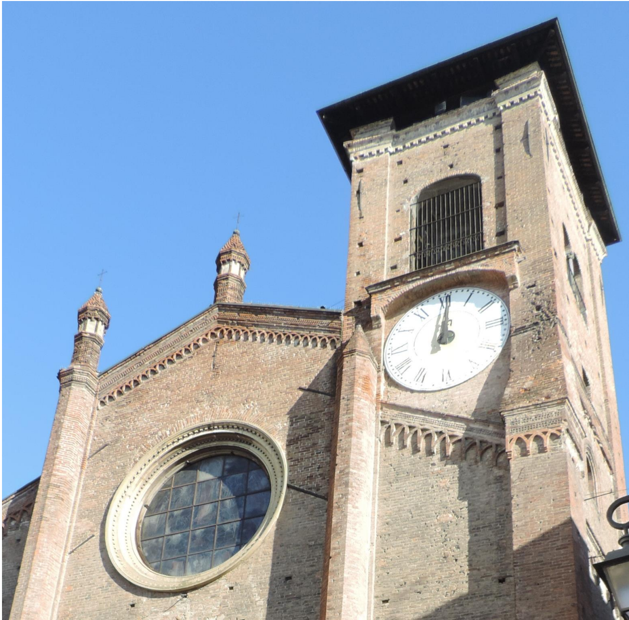
FOTOGRAFIA 131 – GLI ARCHETTI INCROCIATI, LA CORNICE DI CORONAMENTO E I PINNACOLI
