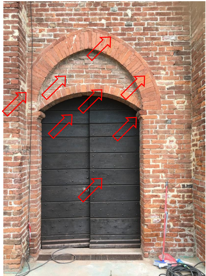
FOTOGRAFIA 183 – L'ATTUALE ENTRATA LATERALE DAL CORTILE CON IL PORTALE E L'ARCO DI SCARICO NEOGOTICO
