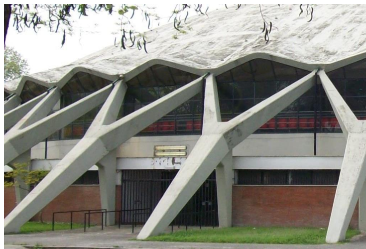
Figure 17 Palazzetto dello Sport (Rome) [15]
