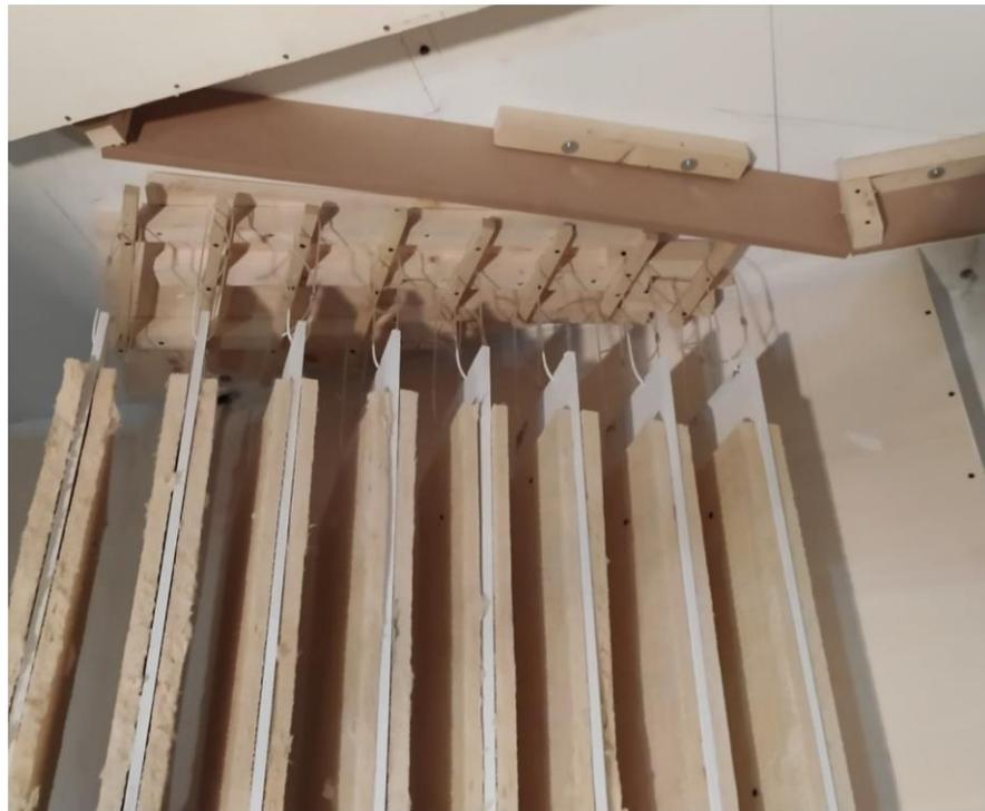
*Figura 91 - Baffles assemblati*
