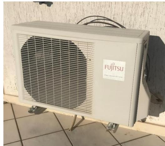
Figura 2.20 – Unità esterna pompa di calore
