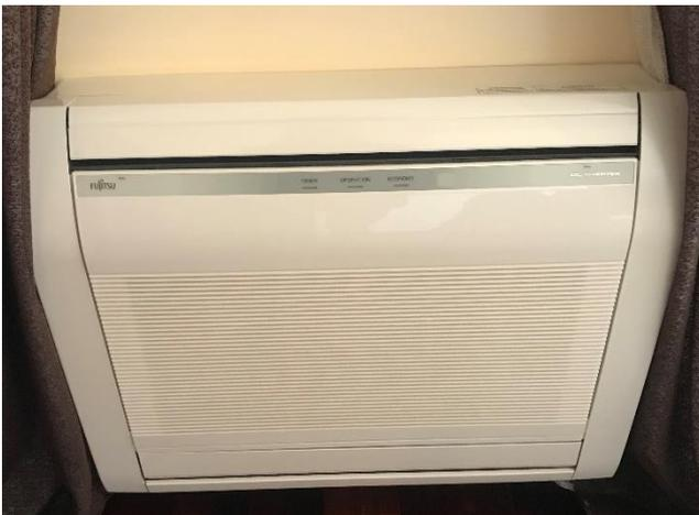
Figura 2.19 – Ventilconvettore
