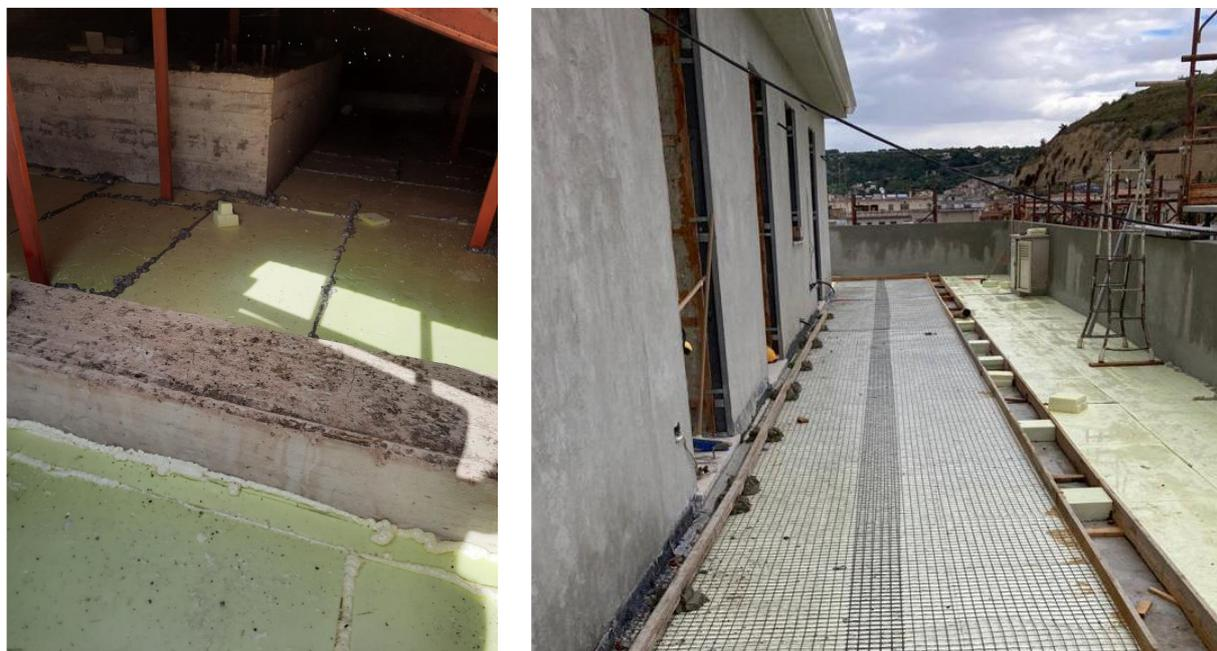
Figura 3.5 – Isolamento termico “Solaio in laterocemento (verso sottotetto)”, a sinistra, e “Copertura piana praticabile in laterocemento”, a destra.
