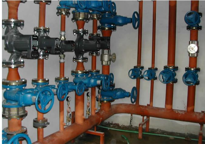
Figura 1.5: Esempio di corrosione galvanica di tubature dovuta all'utilizzo di materiali diversi, più nobili e resistenti, per le valvole.<sup>[4]</sup>
