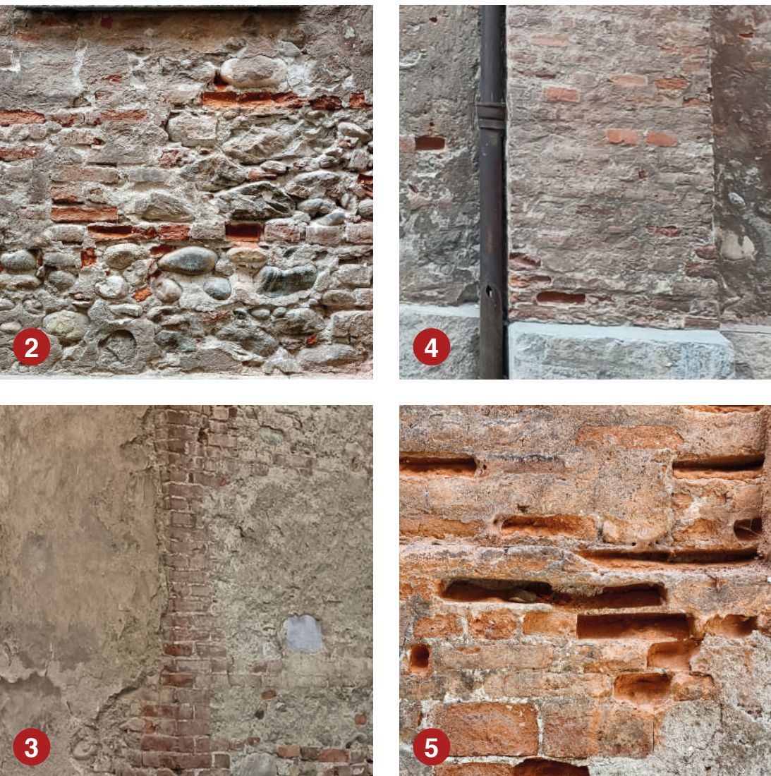
Fig. 2 Dettaglio della tessitura muraria della facciata sud
