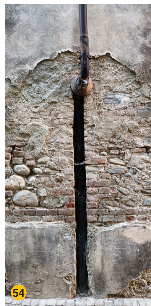
53_Sistema di smaltimento delle acque meteoriche. Fonte: Musso, G. e Copperi, G. (1912). Particolari di costruzioni murali e finimenti di fabbricati , Torino, G. B. Paravia, tav. XXX / 54_Pluviale incassato nella muratura
