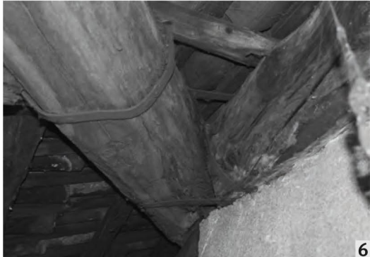
NODO C Le travi secondarie qui sono legate alle principali mediante una cintura in ferro.
