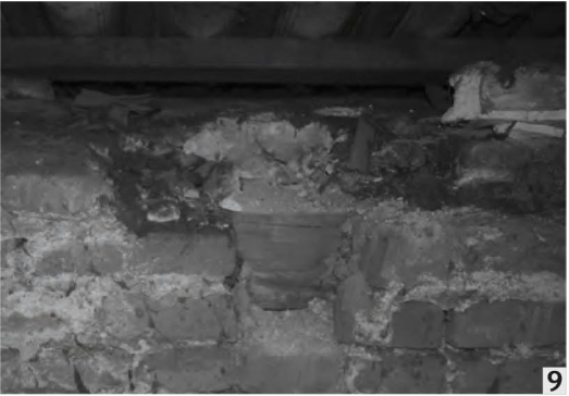
NODO C Le travi secondarie qui sono legate alle principali mediante una cintura in ferro.
