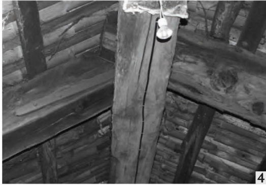
NODO A Puntoni connessi mediante caviglia di ferro come indicato dal Capitolato.
