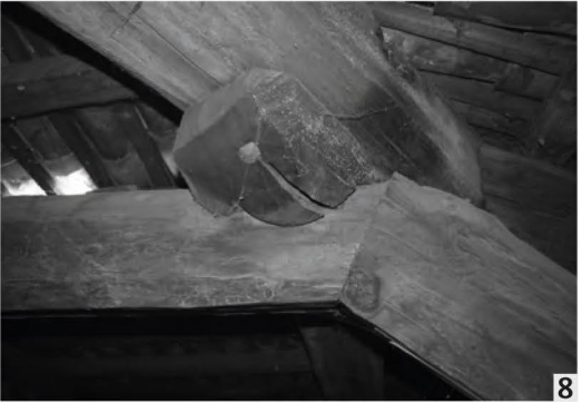
NODO B Appoggio delle travi secondarie sulla trave di colmo. Non è rilevata la presenza di elementi connettivi.
