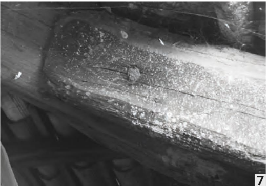
NODO A Puntoni connessi mediante caviglia di ferro come indicato dal Capitolato.
