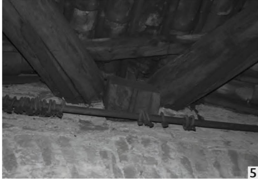
NODO B Appoggio delle travi secondarie sulla trave di colmo. Non è rilevata la presenza di elementi connettivi.
