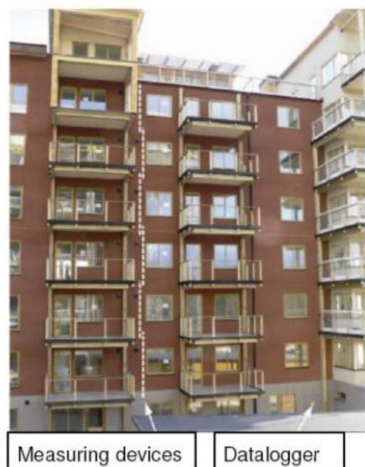
Figura 20. Fotografia con il posizionamento dei sensori esterni. (fonte: E. Serrano, Overview and Summaries of Sub Projects Results. Växjö University, 2008.)
