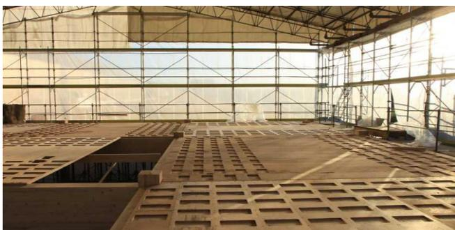
Figura 25. Fotografia della parte superiore del solaio biassiale.
