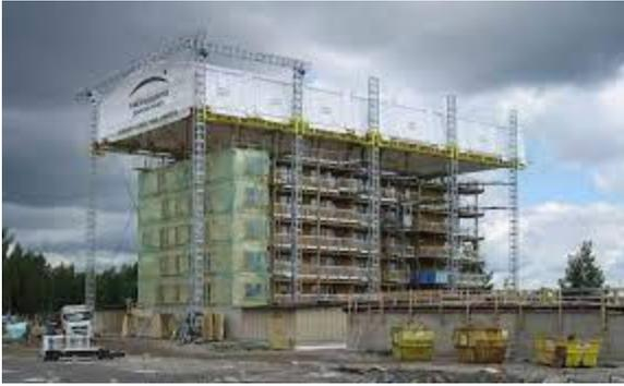
Figura 13. Fotografia delle opere di costruzione del primo edificio. (fonte: E. Serrano, Limnologen-Experiences from an 8-storey timber building, International Houlzbau – forum, 2009.)
