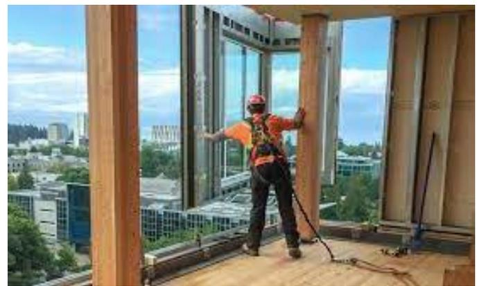
Figura 39. Fotografia del posizionamento di una parete angolare. (fonte: <https://canada.constructconnect.com/joc/news/projects/2018/10/groundbreaking-brock-commons-blazes-new-construction-trail>)
