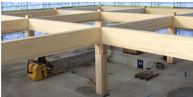
Figura 24. Fotografia del telaio post-teso.
