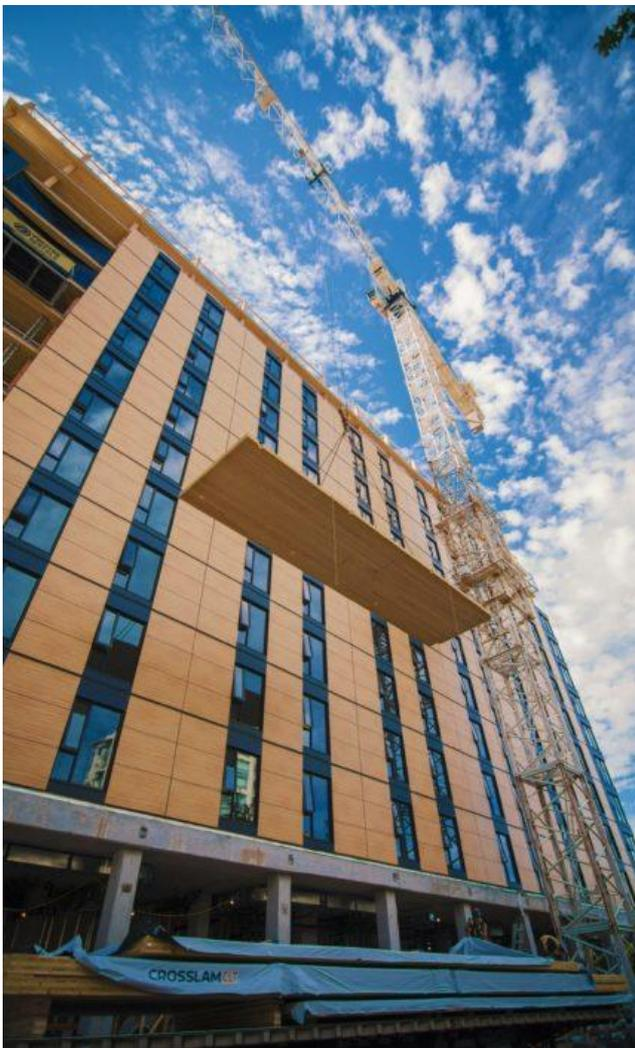
Figura 37. Fotografia del posizionamento di un pannello. (fonte: <https://www.constructioncanada.net/b-c-city-to-not-allow-12-storey-tall-wood-buildings/>)
