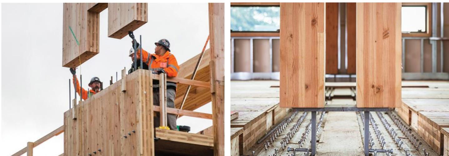
Figura 65. Fotografia dell'istallazione dei pannelli e della carpenteria metallica di collegamento dei componenti.
