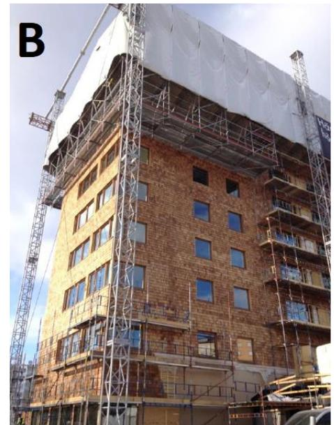
Figura 128. Fotografie delle strutture di copertura temporanee utilizzate in alcuni cantieri svedesi: A) Limnolgen (2009); B) Strandparken (2013); C) Åsbovägen (2015).
