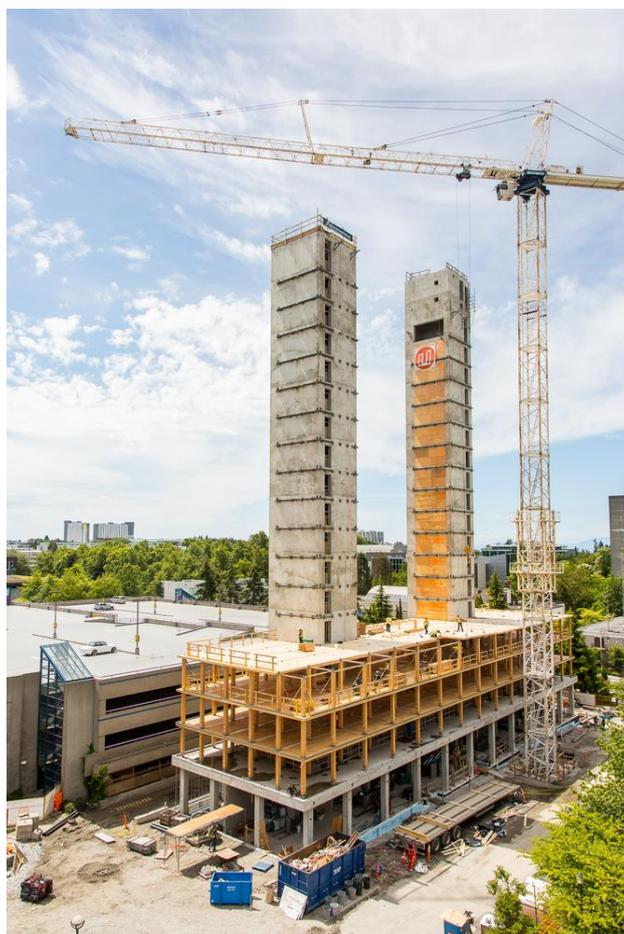
Figura 36. Fotografia dei lavori di assemblaggio dei piani bassi.
