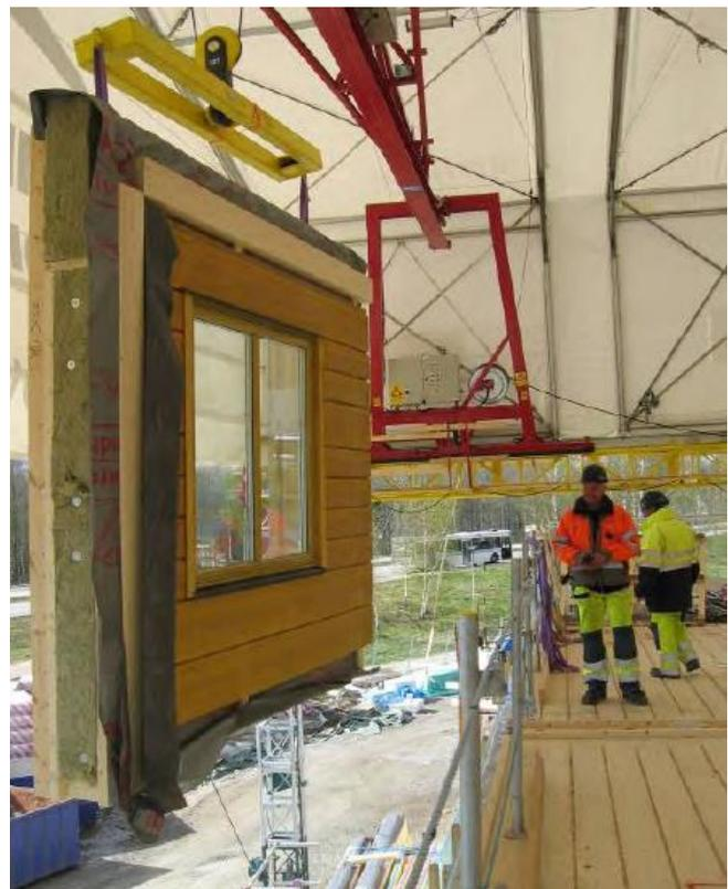
Figura 19. Fotografia delle opere di costruzione del primo edificio. (fonte: A. Rosenkilde, K. Jarnero, M. Axelson, Flervåningshus med trästomme– Uppföljning av Kv Limnologen och Kv Rya, Rydebäck, SP Sveriges Tekniska Forskningsinstitut, Rapport 2018.)
