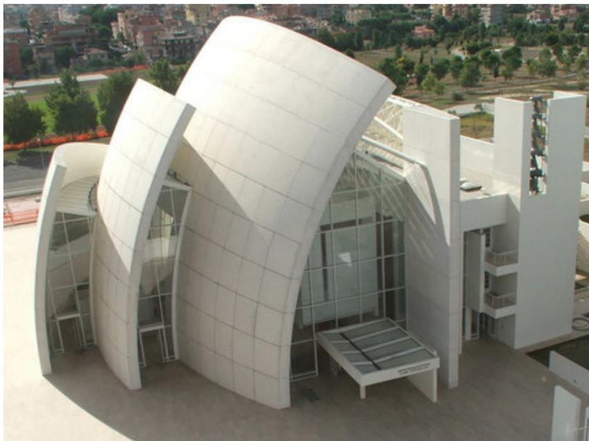
**Figura 8**- Chiesa di Dio Padre Misericordioso a Roma, esempio di utilizzo del cemento fotocatalitico [26]
