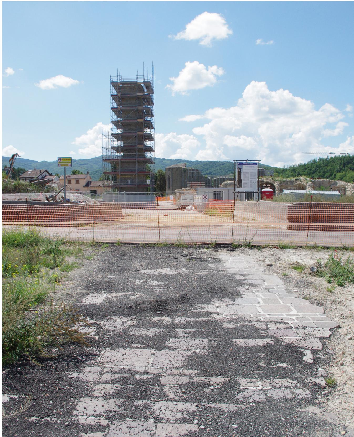
Figura 5.3 - Stato di fatto di Via Roma dove è previsto lo scavo per la posa in opera dei sottoservizi principali. Foto scattata dall'autore in data 2022/08/26.
