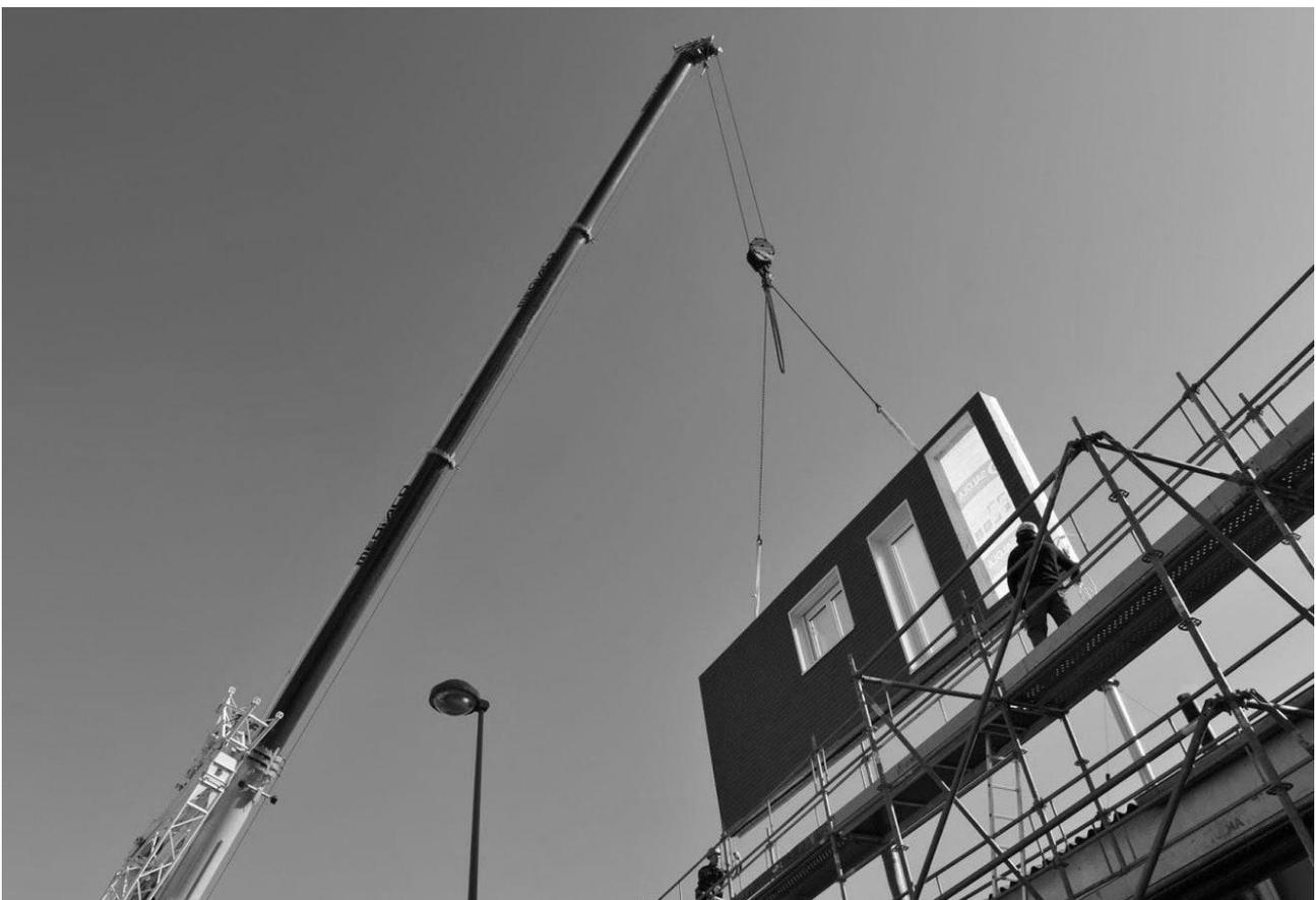
Figura 94\_ Posizionamento in opera del modulo facciata prefabbricata.
