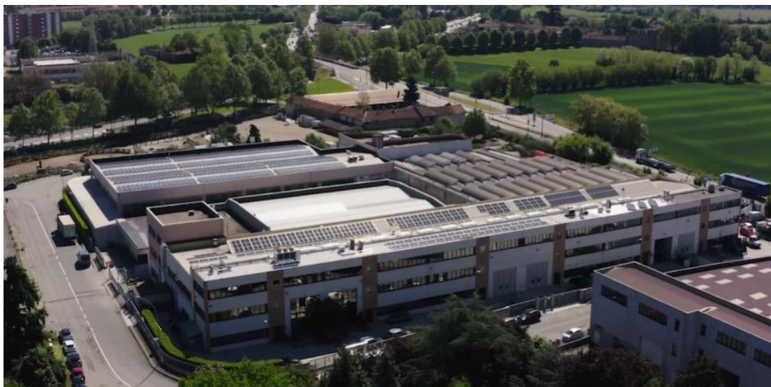
Figura 2.9- Impianto fotovoltaico sulla sede di Collegno [20]
