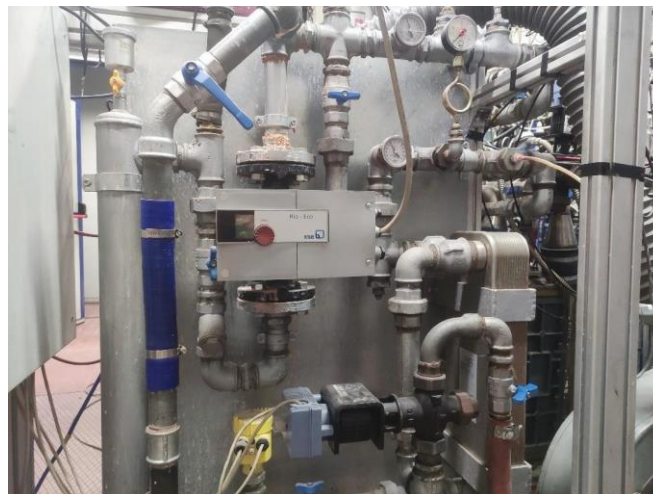
Figure 19: sistema di raffreddamento motore CoolCo
