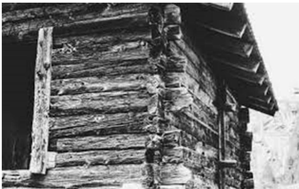
Sistema costruttivo block-bau
