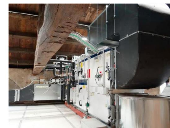
Configurazione delle prese d'aria circolari (sinistra); AHU installata nel sottotetto (destra), pag. 429-430.
