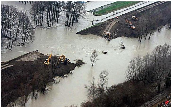
*Figura 3-18 – Breccia sull'argine di San Matteo, lungo il fiume Secchia. Il collasso è probabilmente dovuto ai fenomeni di erosione interna innescati dalle tane dei tassi europei (Taccari, 2015)*
