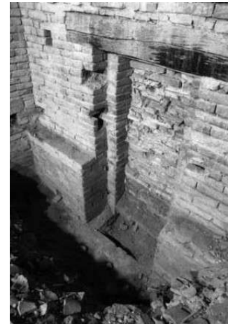
Figura 6.8: Resti della porta per accedere al sottotetto ([33])
