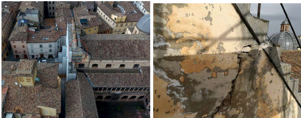
(a) Vista aerea del fronte con ponteggi
