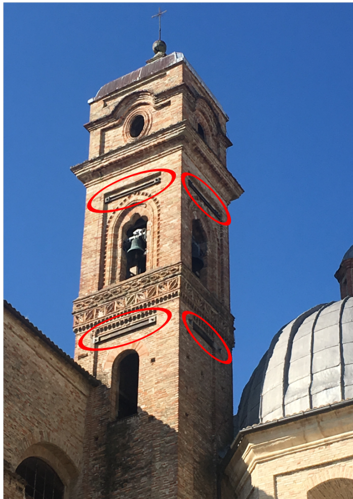
Figura 6.13: Particolare dei tiranti presenti sul campanile ([32])
