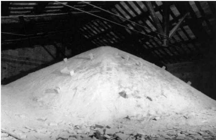
Figura 6.7: Materiale di riporto nei quattro angoli di risulta della volta ([33])
