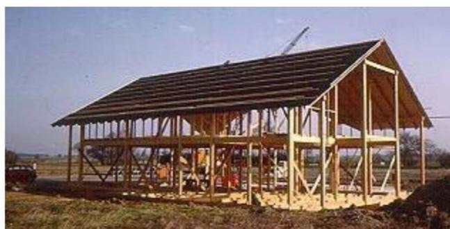
*Figura 6 - Sistema costruttivo in telaio di legno*
