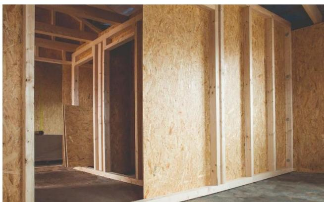
Figura 9 - Lastra OBS su struttura a Platform Frame
