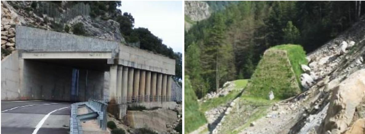
*Figura 3.1 – Sulla sinistra un esempio di una galleria paramassi, a destra un esempio di rilevato paramassi*
