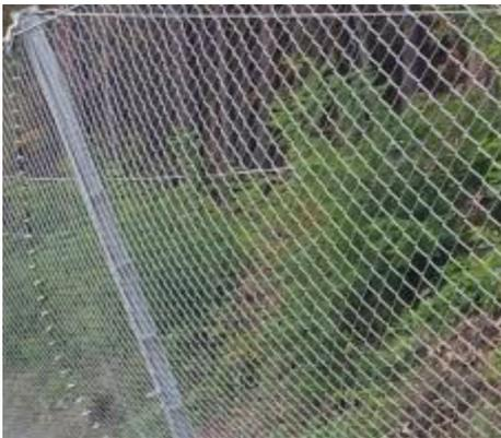
Rete secondaria a singolo filo a singola torsione (maglia romboidale)
