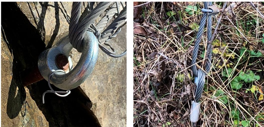
Figura 3.6 – Esempio di una barra in acciaio cementata con golfare (sulla destra) e di una doppia fune spiroidale ripiegata in foro e cementata nel terreno con redancia (sulla sinistra)
