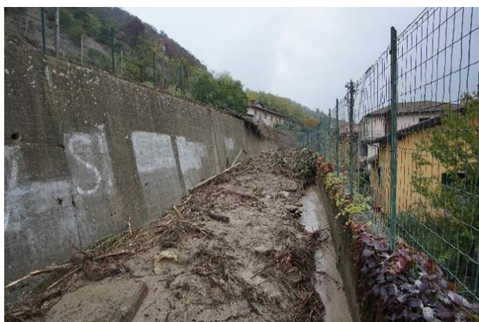
Figura 15 Strada comunale di Gavi ricoperta da materiale franato (Fonte: Arpa Piemonte)
