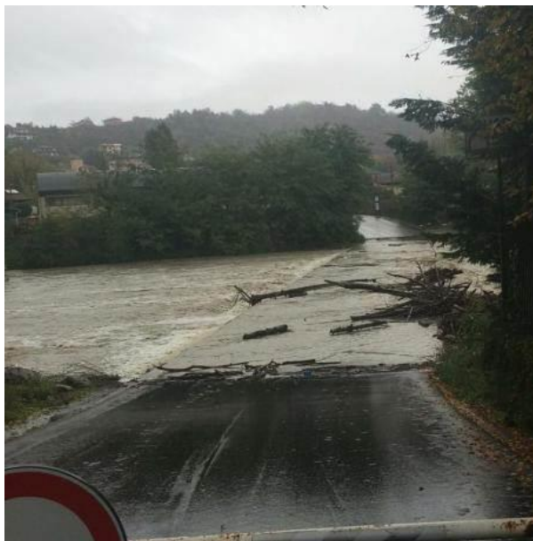
Figura 14 Guado sul Torrente Lemme a Gavi. (Fonte: Arpa Piemonte)
