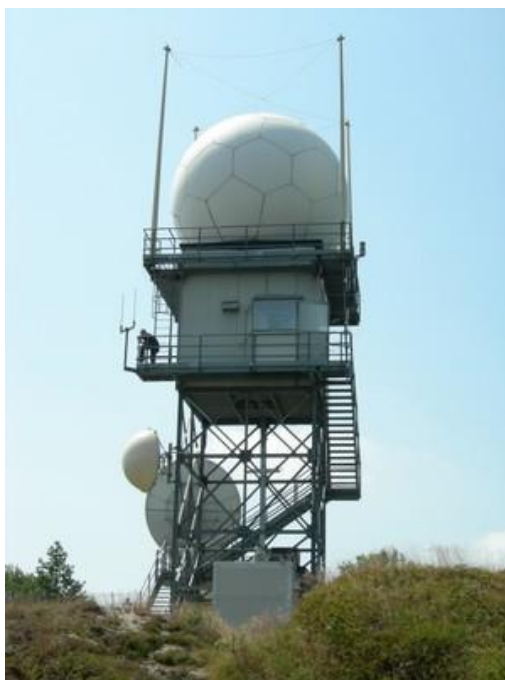
Figura A1 6 Radar di Monte Settepani (Fonte: Arpa Piemonte)
