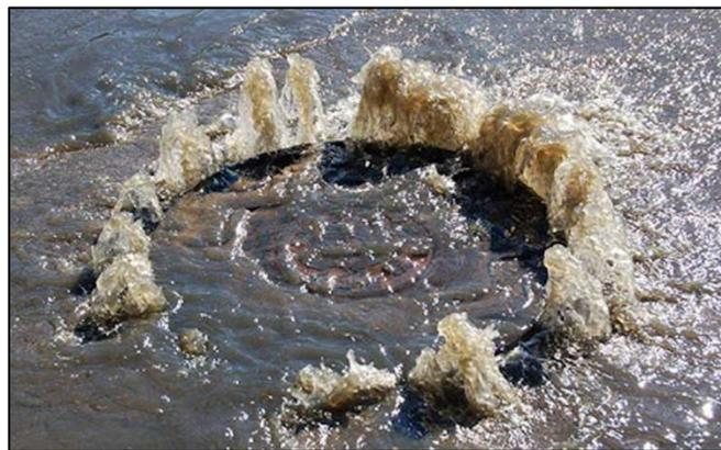
*Figura 1: Esempio di rigurgito di una fognatura [4]*
