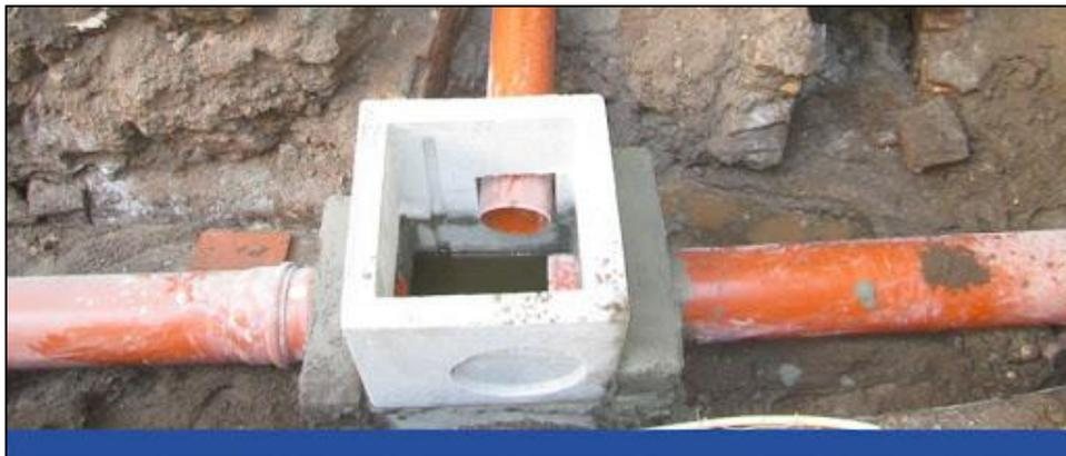
Figura 3: Esempio di un pozzetto [1]
