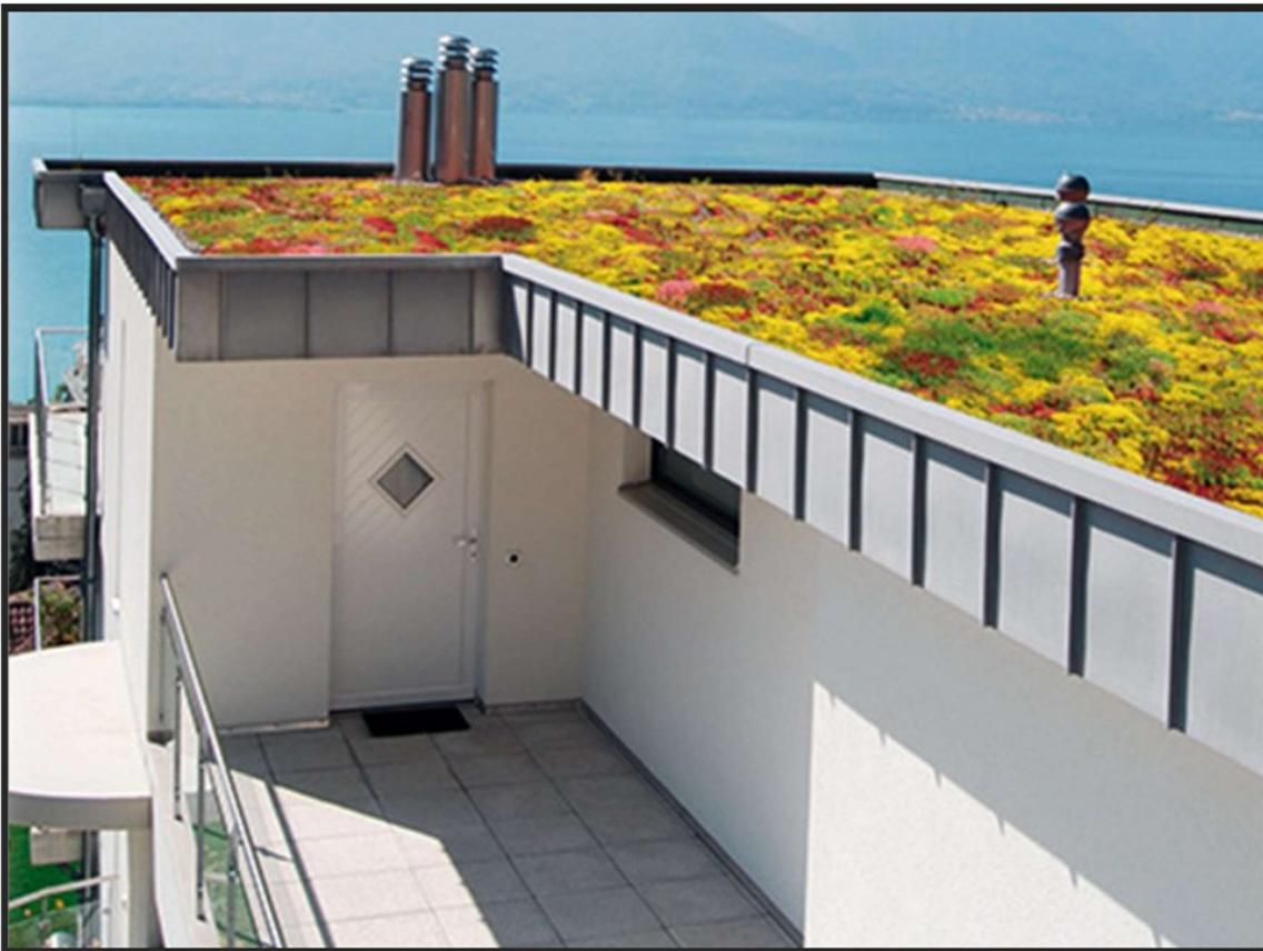
Figura 2.4- Immagine di un tetto verde estensivo (Web)
