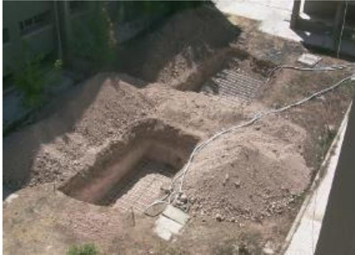
Figura 3.1: Scambiatori lato terreno a diverse profondità
