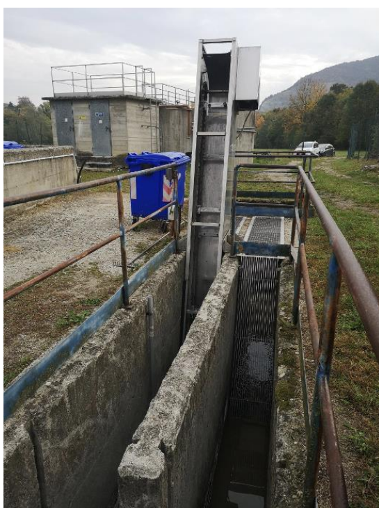
Figura 27 - Dettaglio grigliatura manuale (dx) ed automatica (sx)
