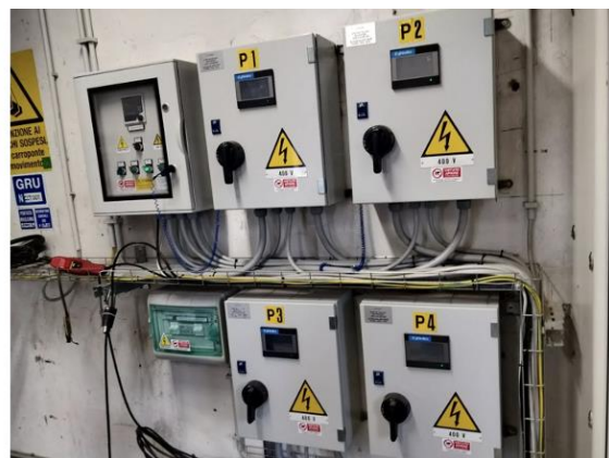
Figura 33 - Dettaglio pompe di sollevamento e relativi controlli
