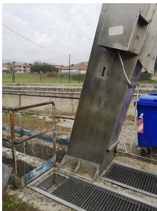
Figura 27 - Dettaglio grigliatura manuale (dx) ed automatica (sx)
