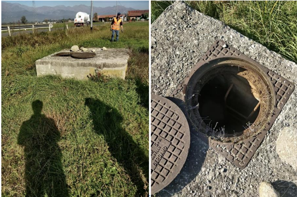
Figura 20 - Sfioratore fognatura
