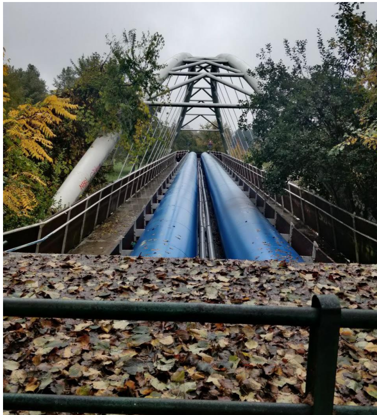
Figura 62 - Sollevamento aereo acquedotto
