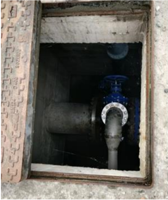
Figura 36 - Dettaglio tubazione e saracinesca
