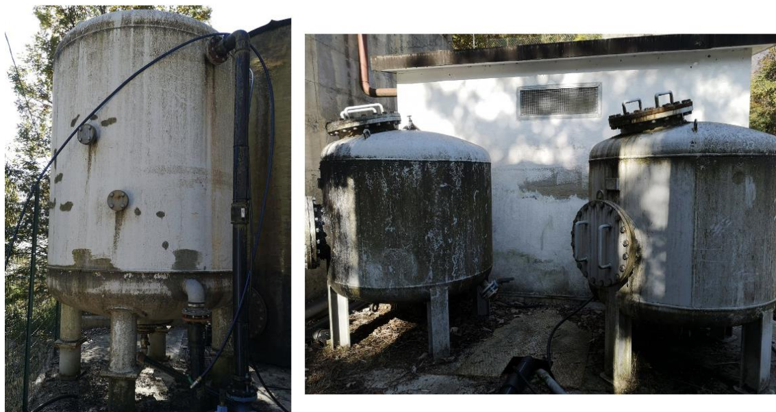
Figura 39 - Filtri a carbone
