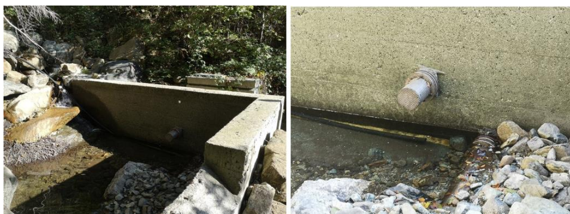
Figura 46 - Dettaglio presa da fiume
