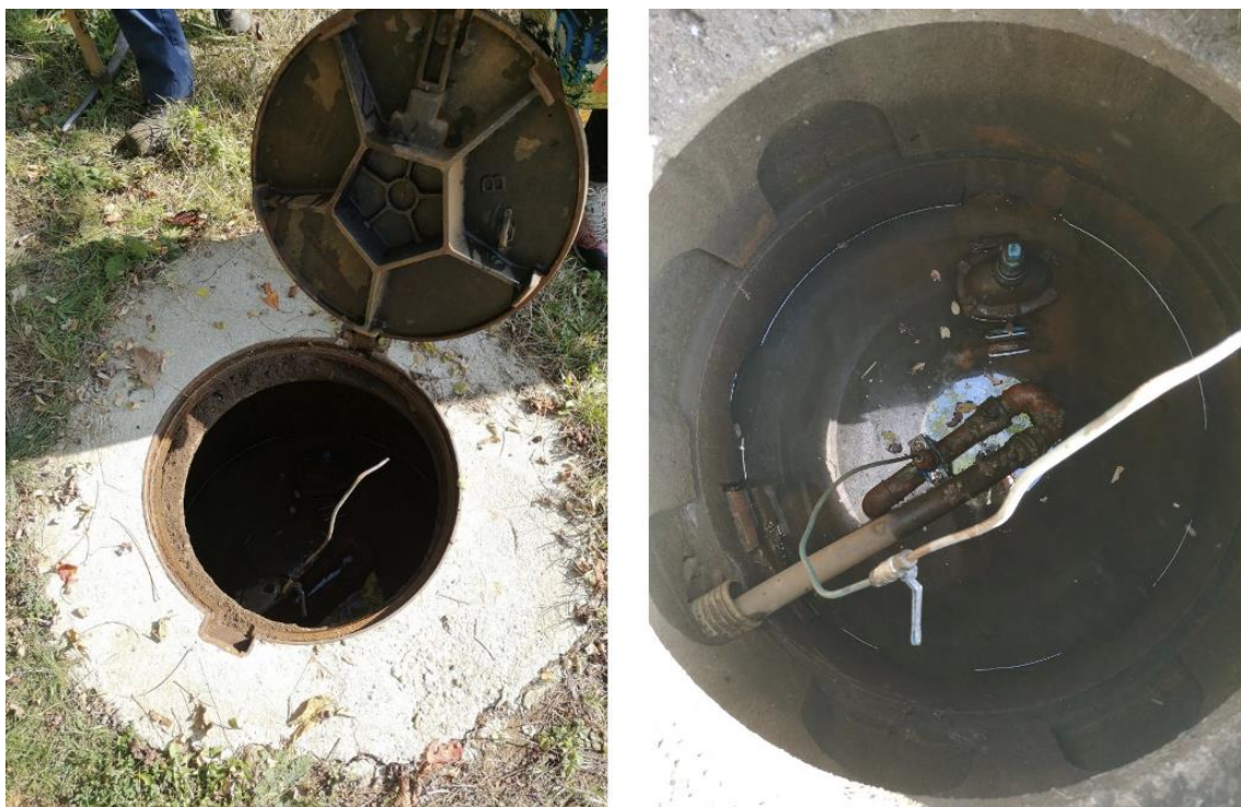
Figura 50 - Pozzeto di campionamento
