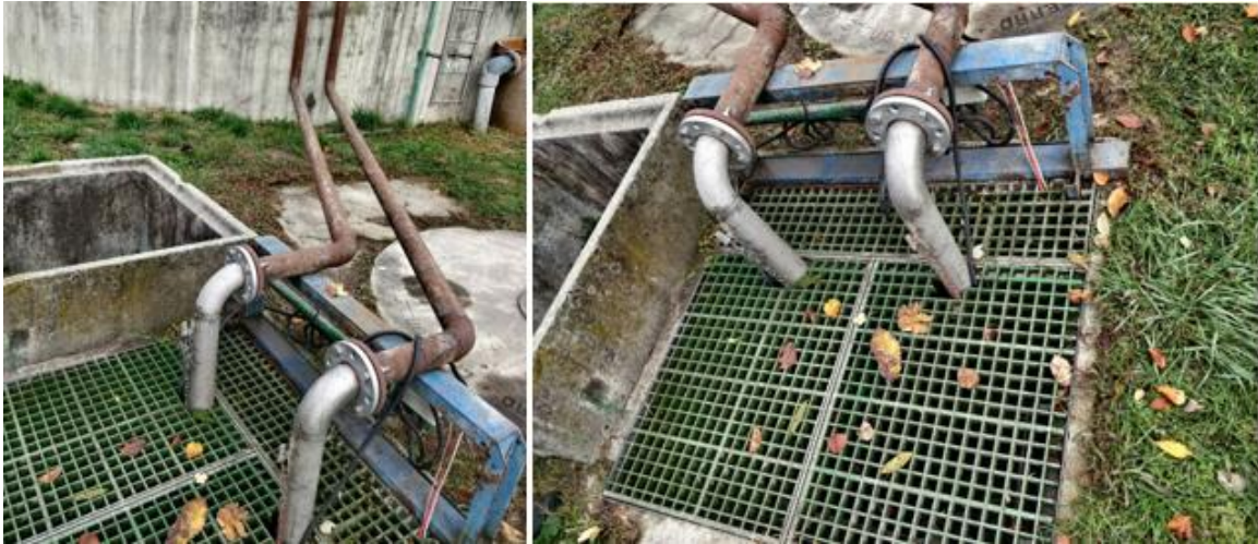
Figura 28 - Dettaglio sollevamento
