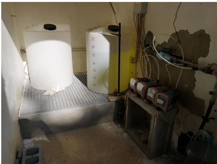
Figura 40 - Serbatoio ipoclorito
