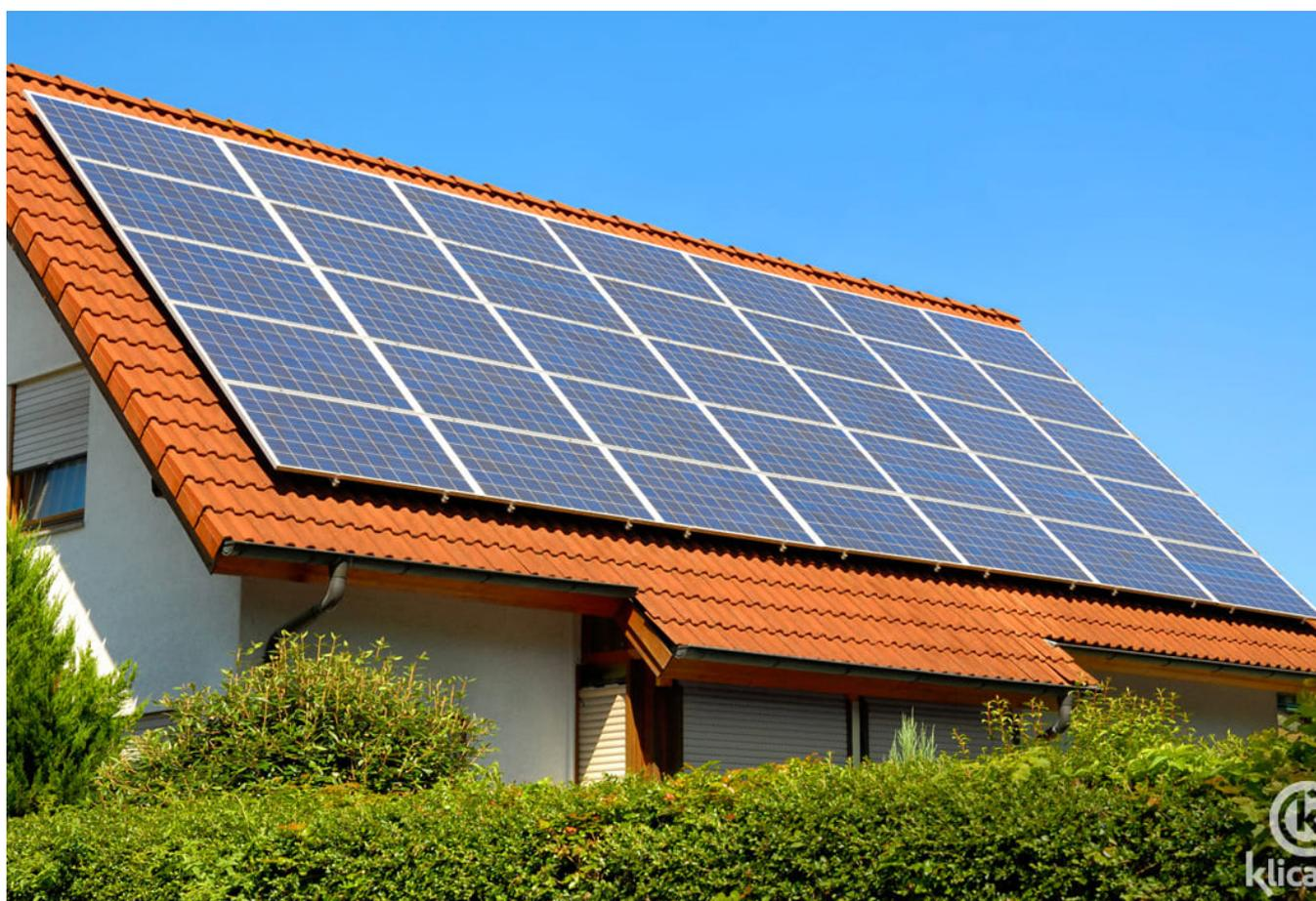
*Un esempio di impianto fotovoltaico applicato alla copertura (BAPV).*
