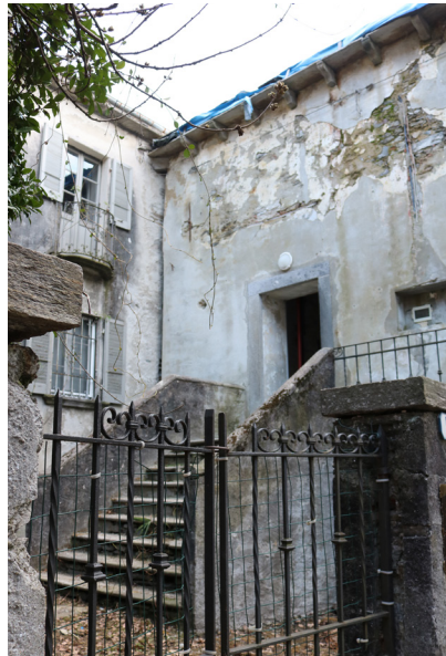
Figura 3.25: Scala di accesso
