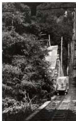
Fig.46.2 Piano inclinato per il trasporto mediante vagoni su rotaie della piritite dalle gallerie agli impianti di laveria.
