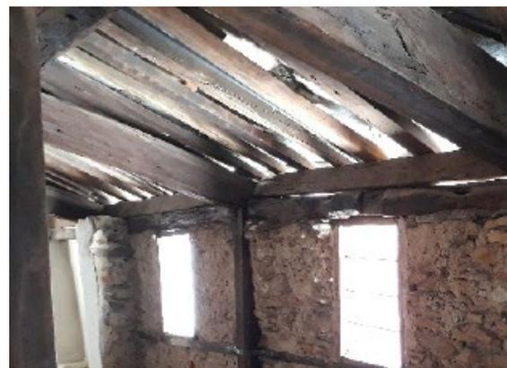
Fig.24.3 Sottotetto in travi lignee.
