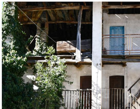
Fig. 13.5 Ballatoio privo di parapetto dell'edificio numero 37.
