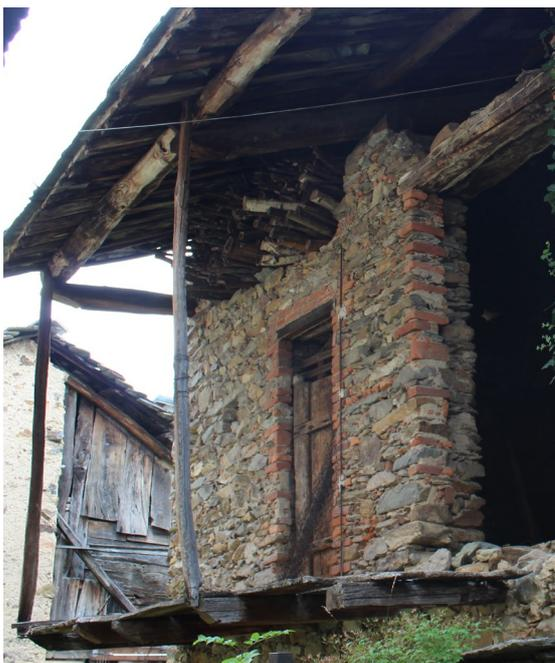
Fig.19.5 Ballatoio con montanti in legno dell'edificio numero 10. Fotografia del 27 luglio 2021.
