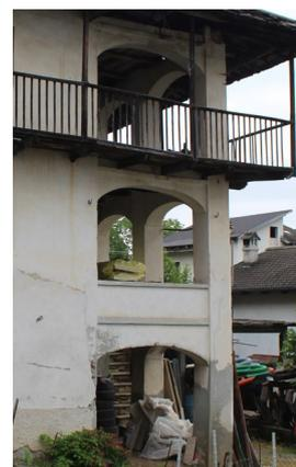
Fig.10.5 Sistema ad angolo portico, loggia e ballatoio dell'edificio numero 4. Fotografia del 3 settembre 2021.
