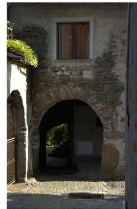
Fig.39.2 Sottopassaggio voltato a botte.
