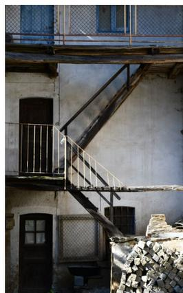
Fig. 15.5 Scala a forbice, edificio numero 37. Fotografia del 3 settembre 2021.
