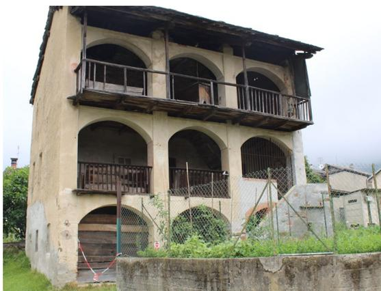
Fig.8.5 Sistema ad angolo portico, loggia e ballatoio dell'edificio numero 49. Fotografia del 27 luglio 2021.
