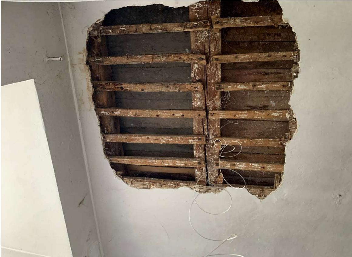
*Foto 5 Solaio in legno al secondo piano*
