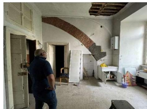
Figura 8 Particolare costruttivo - archi scaricatori.
