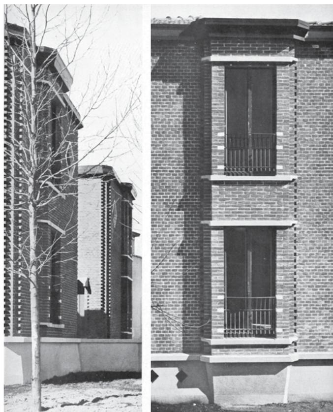
Figg.8 e 9. V. Gregotti, L. Meneghetti, G. Stoppino, Casa per gli operai della Fabbrica tessile Bossi, 1954, Un particolare della soluzione di spigolo della muratura. Le aperture in colonna di uno dei duplex (In «CasabellaContinuità», n. 219, aprile-maggio 1958, p. 26. Foto di Carla De Benedetti)
