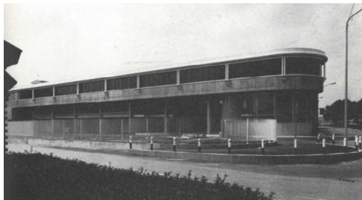
Fig.10. V. Gregotti (Gregotti Associati), Nuovi uffici della Fabbrica tessile Bossi, 1980-84, fronte esterno, lungo 85 metri, è ritmato al secondo piano da una serie di doppi elementi in ferro che servono a portare e ad evidenziare la copertura realizzata con struttura in ferro e solaio in lamiera grecata (in G. Polin, *Gregotti Associati. Nuovi uffici Bossi a Cameri*, in «Casabella», n. 493, luglio-agosto 1983).
