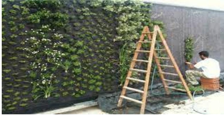
Figura 15 Piantumazione di un muro vegetale
