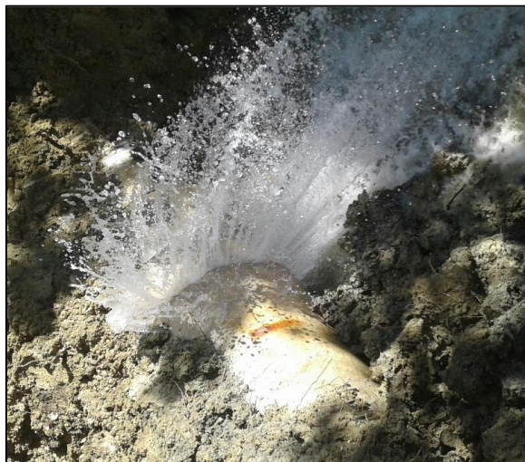
Figura 13 rottura condotta acquedotto Pescara (fonte: bilancio dell'esercizio 2019- CIIP)
