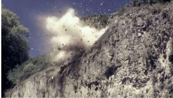
Figura 24. Esempio di disgaggio tramite esplosivo. Immagine tratta da: <https://www.esplosivi.it>
