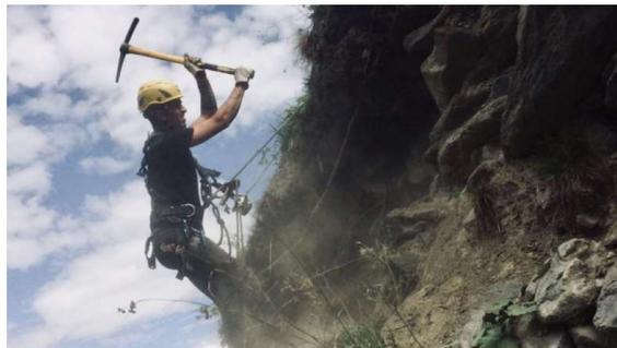
Figura 23. Esempio di disgaggio manuale con picco. Immagine tratta da: <https://worktrade.ch>
