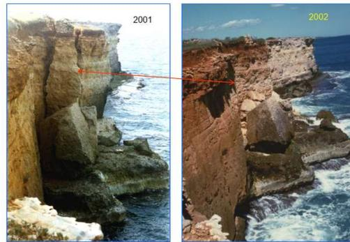
Figura 97. Esempio di ribaltamento in località Mulino d'Acqua, comune di Otranto (LE). Immagine tratta da: <https://www.isprambiente.gov.it>
