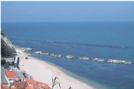
Figura 33. Sistema di barriere sommerse opportunamente segnalate (in secondo piano) ed emergenti (Ligato et al., 2007).
