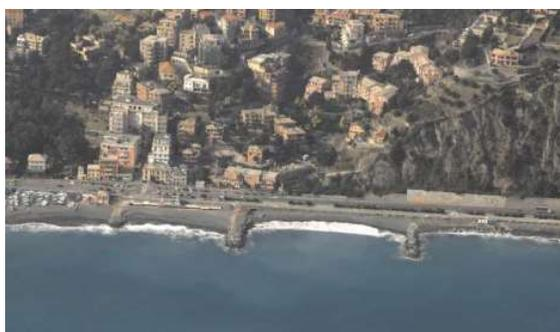
Figura 29. Opera di difesa presso Arenzano (GE), costituita dalla successione di tre pennelli (Ligato et al., 2007).
