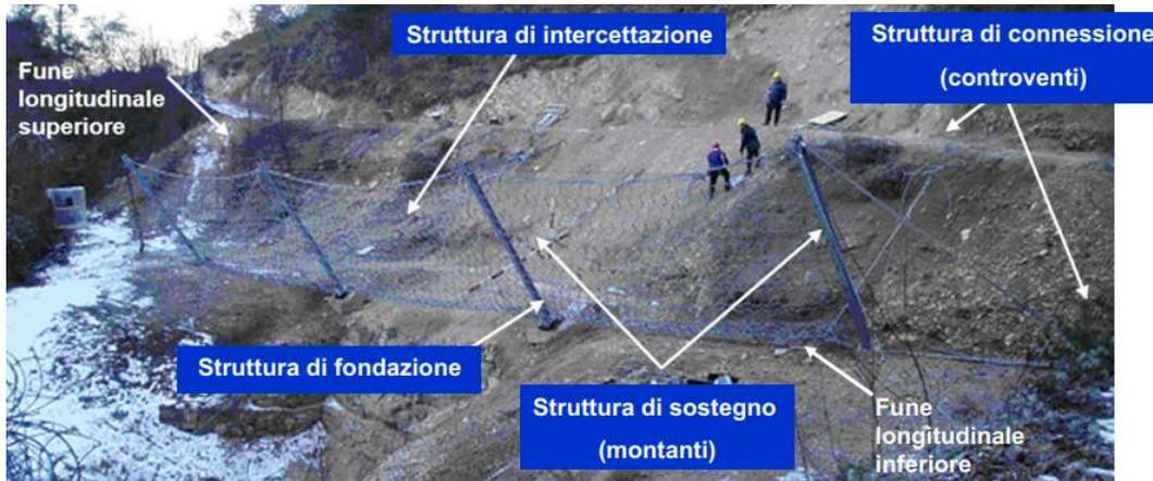
Figura 25. Componenti di una barriera paramassi a rete (Corso di Meccanica delle Rocce, 2019).
