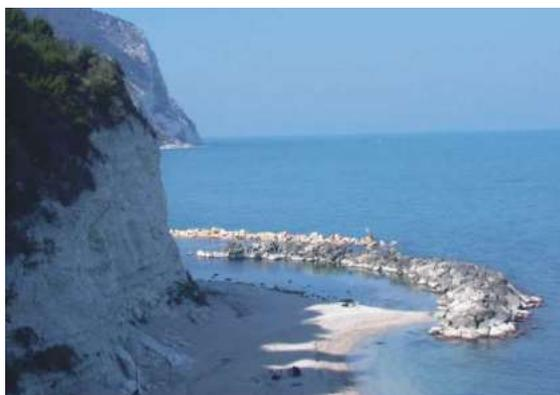
Figura 34. Barriera frangiflutti al piede della falesia del Monte Conero (Marche), che permette una maggiore fruizione turistica dell'area e smorza l'effetto erosivo delle onde incidenti (Ligato et al., 2007).
