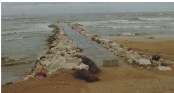
Figura 28. Esempio di pennello (Ligato et al., 2007).
