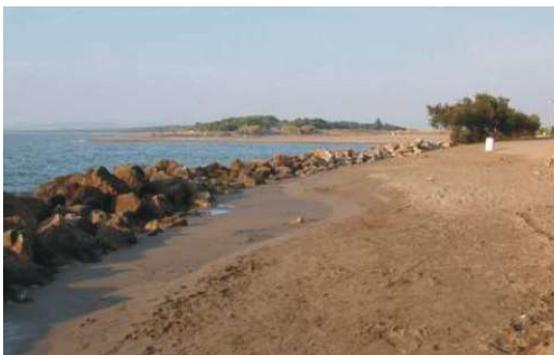
Figura 27. Esempio di barriera aderente (Ligato et al., 2007).
