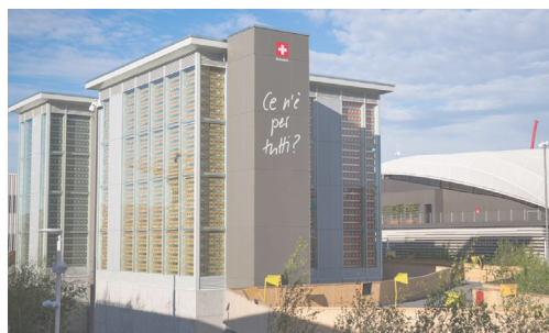
Fig. 41 - Vista esterna del padiglione
