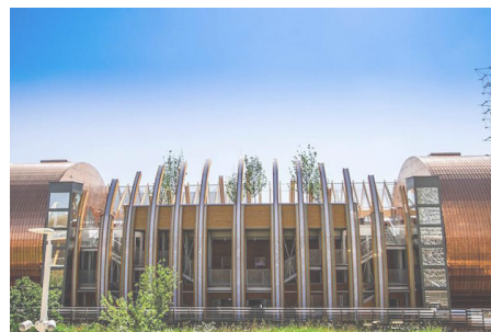
Fig. 46 - Vista esterna del padiglione
