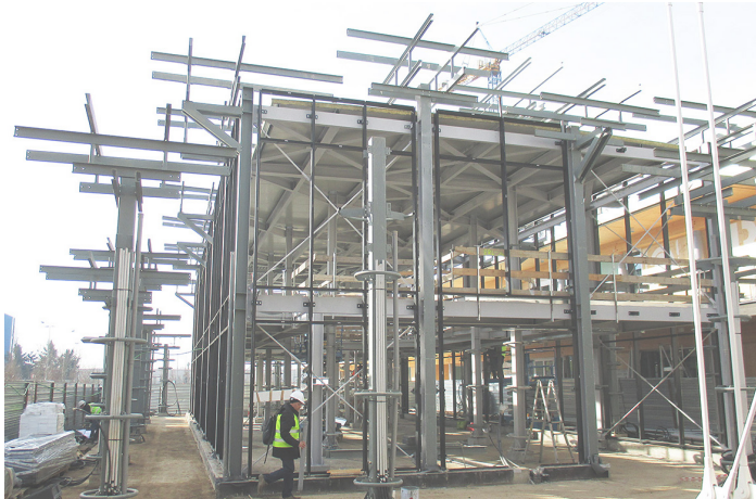
Fig. 21 - Vista esterna della struttura portante in acciaio
