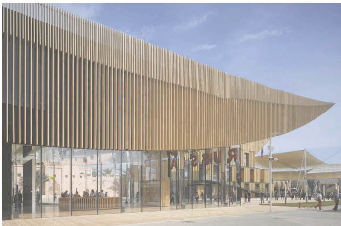
Fig. 7 - Contrapposizione di rivestimento tra il piano terra e il piano primo
