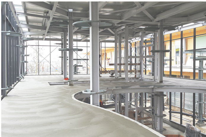
Fig. 22 - Vista interna della struttura portante in acciaio e del getto in c.a.
