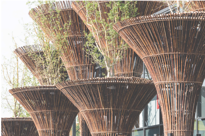
Fig. 18 - Dettaglio dei pilastri in acciaio rivestiti in bambù
