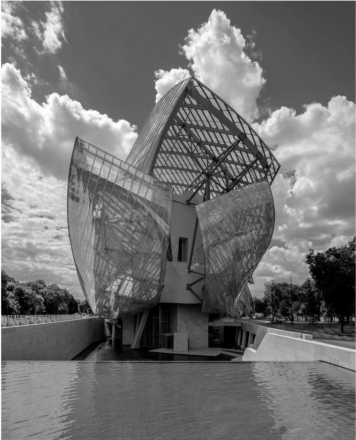
Figura 6.6: Fotografia della *Fondation Louis Vuitton* (Parigi, 2015) progettata da Frank Gehry. La fabbricazione e la generazione di forme digitali forniscono un processo di progettazione più integrato. La società Gehry Technologies ha sviluppato la propria piattaforma software, la *Digital Project*, per realizzare progetti che utilizzano geometrie complesse. Da Larsen N. M. *et al.*, 2016. *Digital Fabrication in Tomorrow's Architecture*. Copenhagen: Arkitektskolen Forlag, p. 7.
