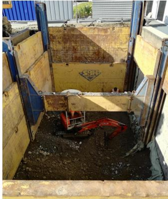
Figura 27: Realizzazione armatura
