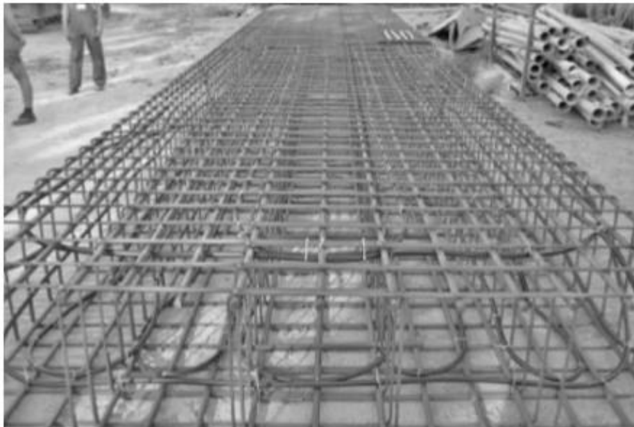
Figura 24: Schema di un diaframma energetico
