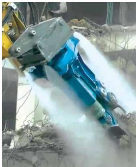
Figura 18. Sistemi abbattimento polvere per cantieri e demolizioni, Eurocooling
