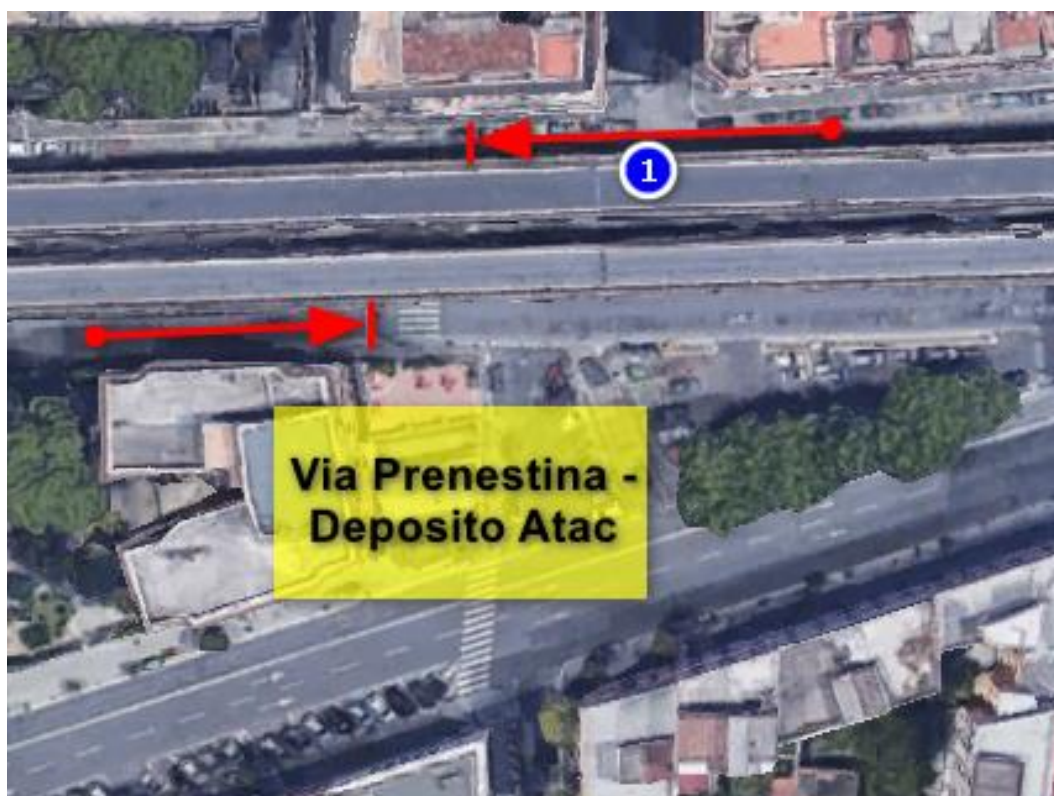
figura 16 Via Prenestina-deposito ATAC, particolare sui flussi in ingresso
