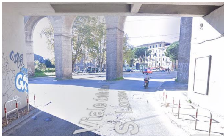
figura 39 sottopasso e accesso al nodo, Via dello Scalo San Lorenzo
