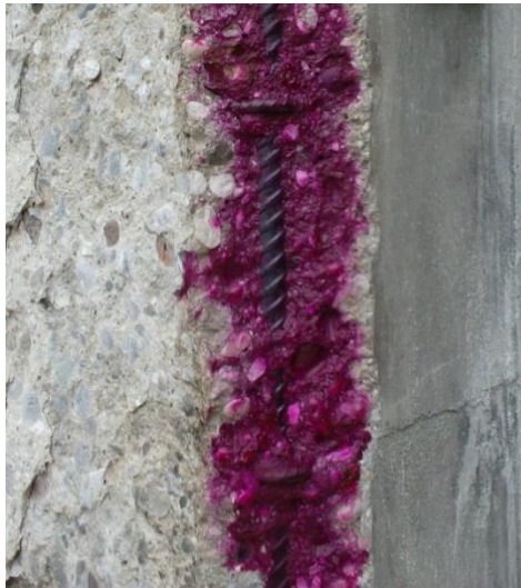
Figura 3.5 - Esempio di prova con fenolfaleina
