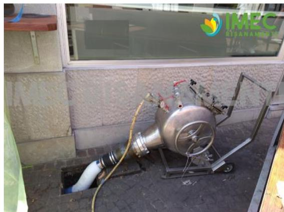
*Figura 4.18 – Inserimento nella condotta del tubolare impregnato*
