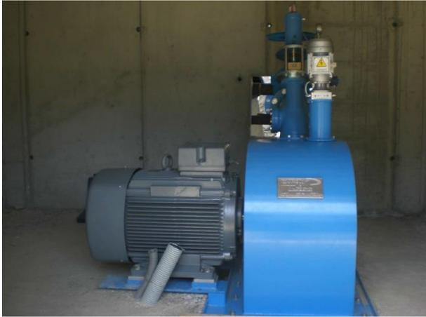
Figura 4.37 – Sistema a turbina installato con generatore
