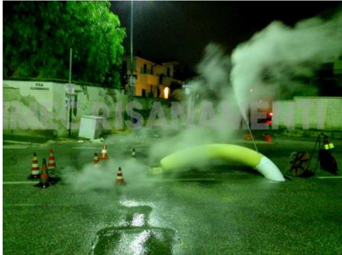
*Figura 4.19 – Polimerizzazione con aria*
