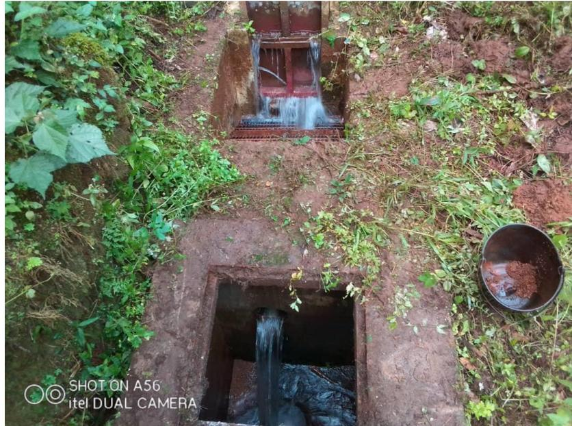
Figura 4.5 – Foto dei primi due tombini della lastra che ricopre la vasca di sedimentazione
