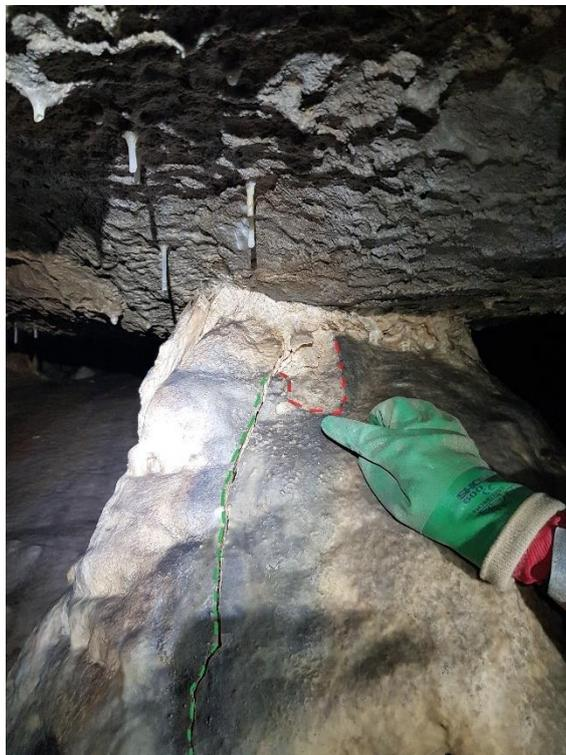
Figura 4.23 – Dettaglio della concrezione 16. La linea rossa tratteggiata indica una zona di distacco del materiale superficiale. La linea verde tratteggiata indica la propagazione di una fessura.
