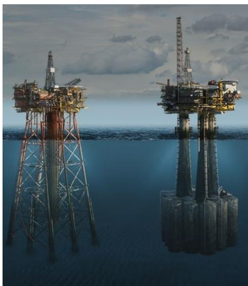
Figura 1: Struttura fissa e a gravità [1]
