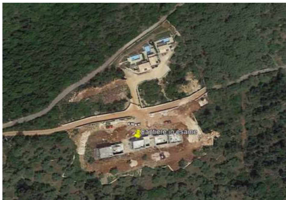
Figura 15: Foto aerea di cantiere del lotto oggetto di esame
