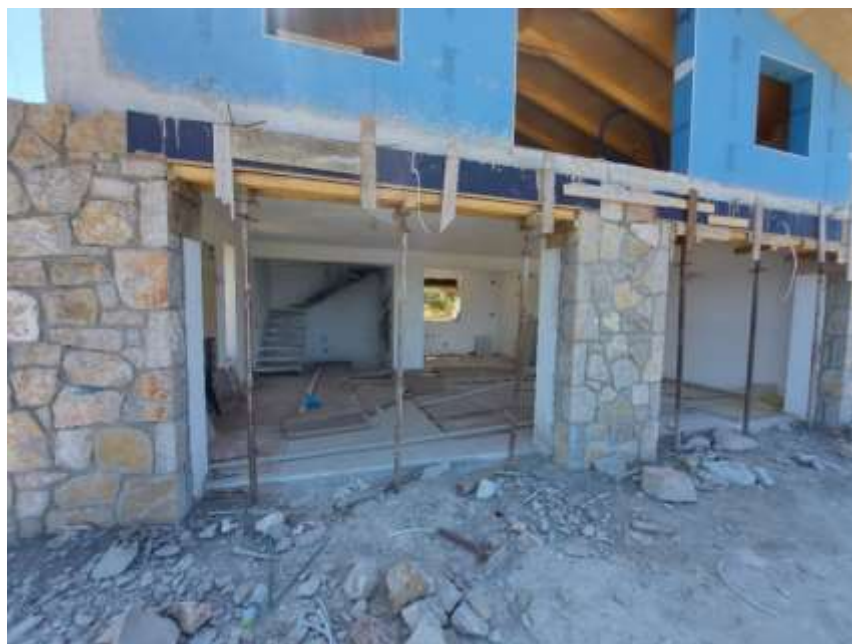
Figura 43: Realizzazione finiture esterne con rivestimento in pietra naturale
