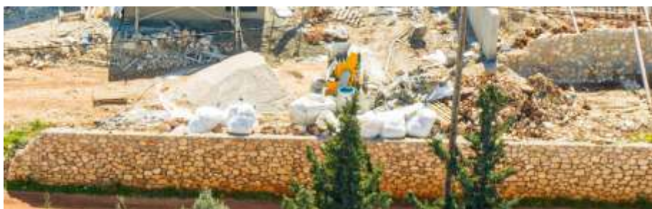
Figura 21: Muro di recinzione del cantiere costruito in pietra
