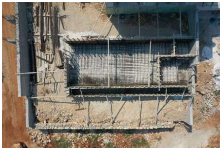
Figura 49: Posizionamento ferri e casseri per il getto della piscina
