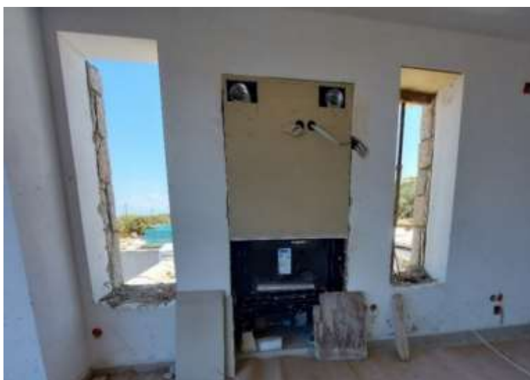
Figura 45: Realizzazione camino prefabbricato
