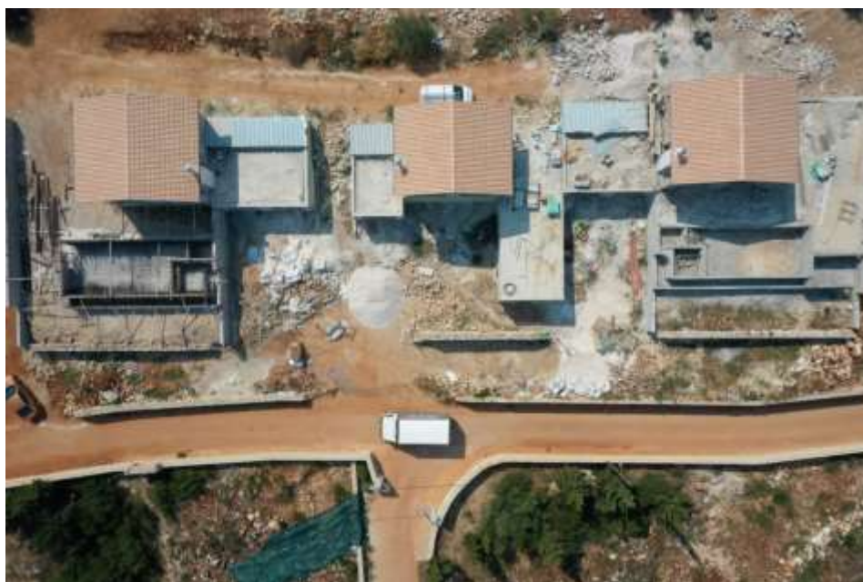
Figura 16: Indicazione della larghezza della strada fuori dal cantiere in confronto con un camion che porta i materiali
