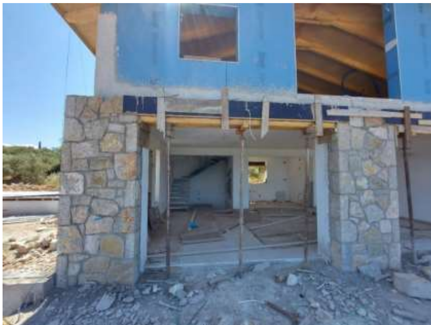
Figura 44: Realizzazione dello spazio per gli infissi e serramenti
