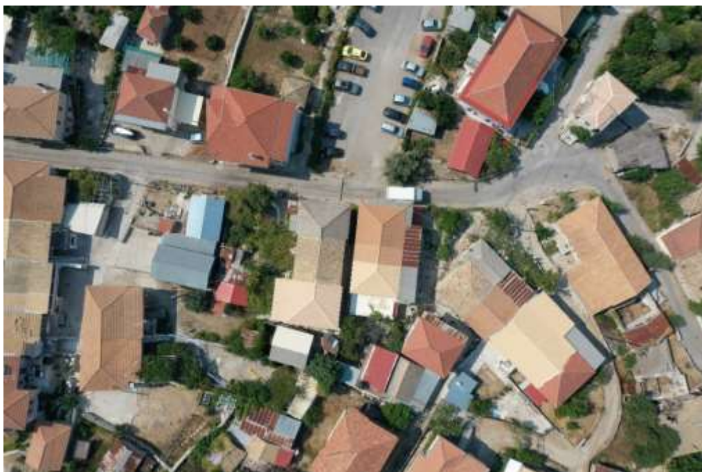
Figura 11: Confronto della strada con il passaggio di un camion che trasporta materiali al lotto oggetto di esame
