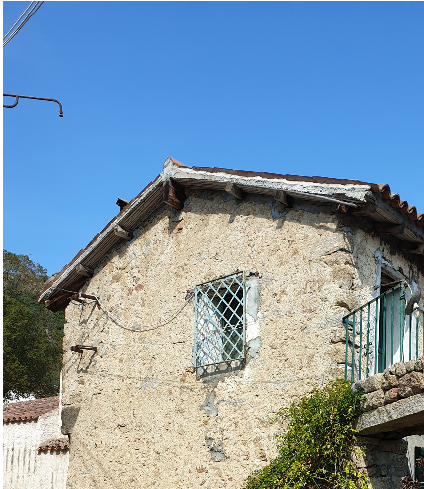
Figura 85 - Copertura in cui il canniccio sporge rispetto al filo muro (Foto dell'autore, 2021)
