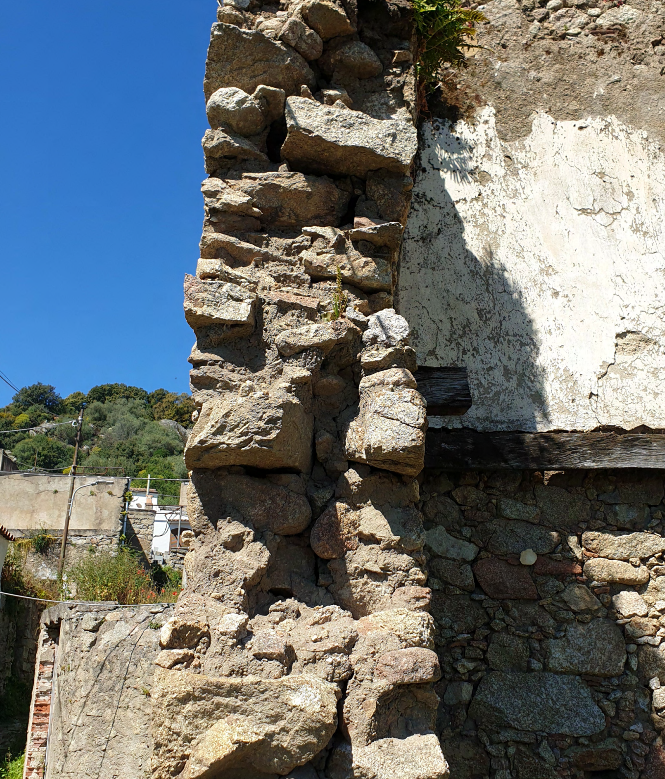
Figura 75 - Sezione muraria di tipo M2 (Foto dell'autore, 2021)
