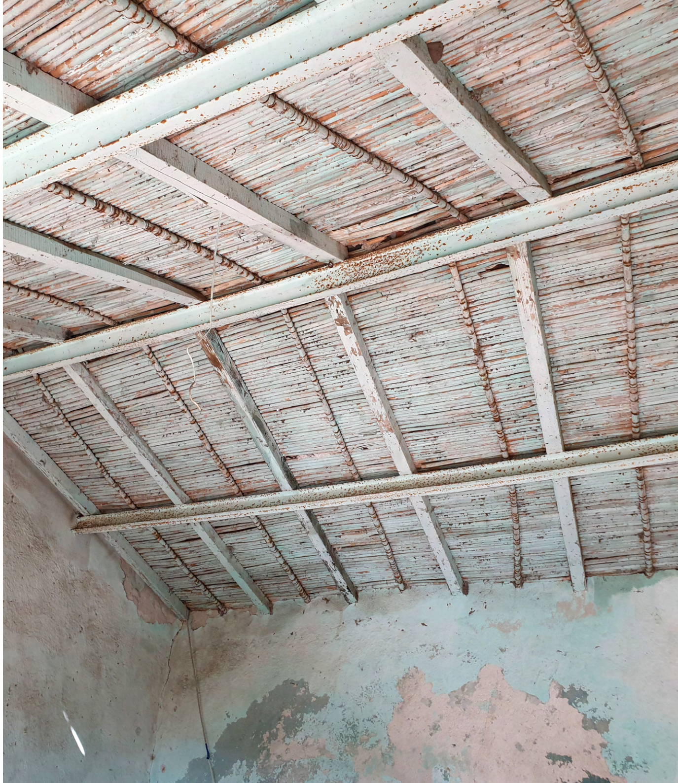
Figura 112 - Copertura a due falde - interno (Foto dell'autore, 2021)
