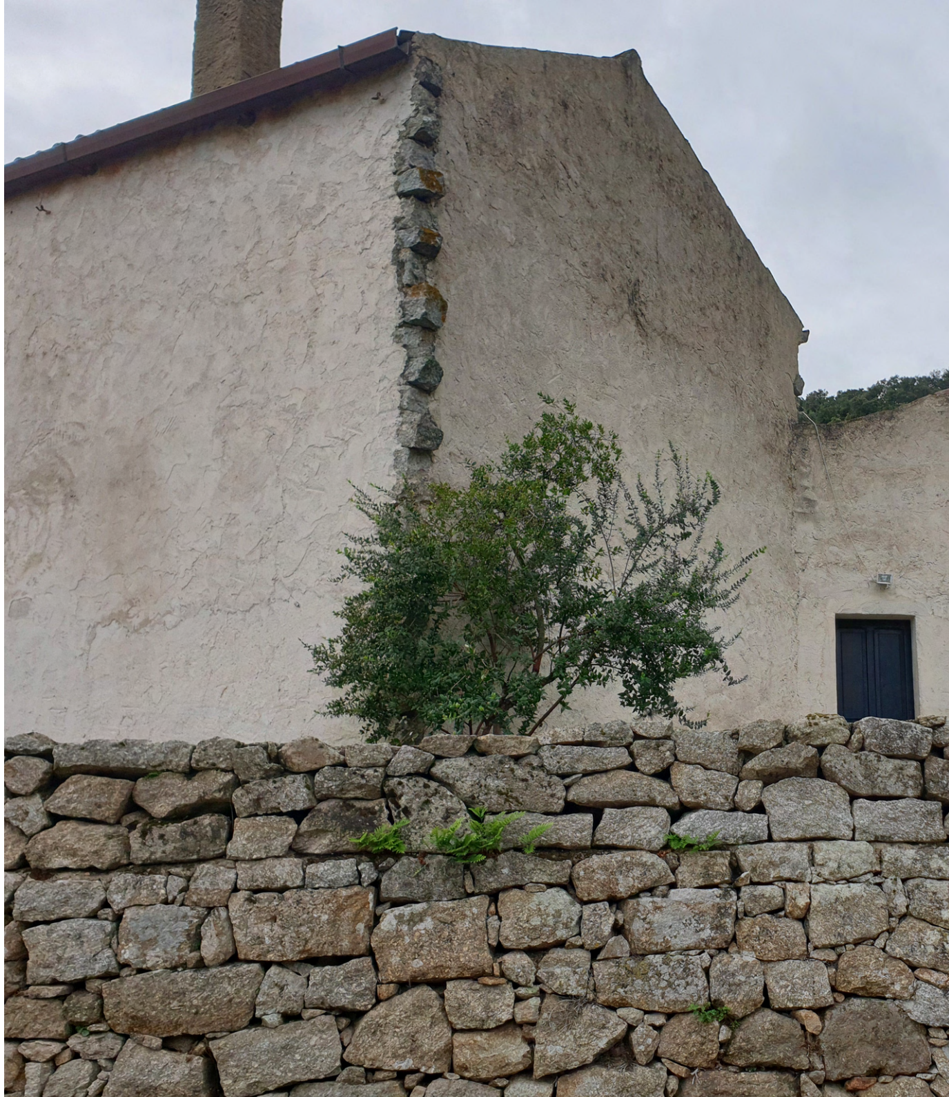
Figura 81 - Edificio di tipo unitario dotato di morse (Foto dell'autore, 2021)
