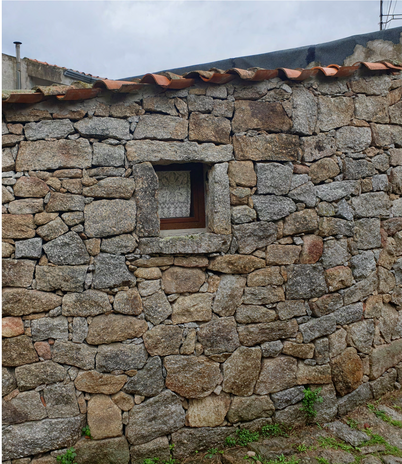
Figura 64 - T2 - Intasamento della corte (Foto dell'autore, 2021)
