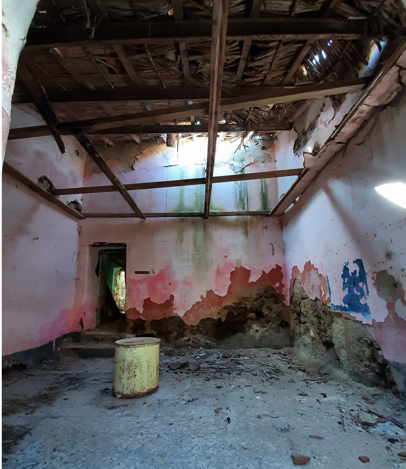
Figura 87 - Solaio in legno di una cellula elementare con soppalco.
