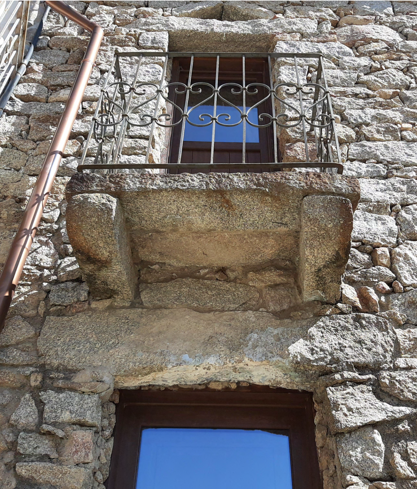
Figura 92 - Poggiolo con lastra e sporti in granito (Foto dell'autore, 2021)
