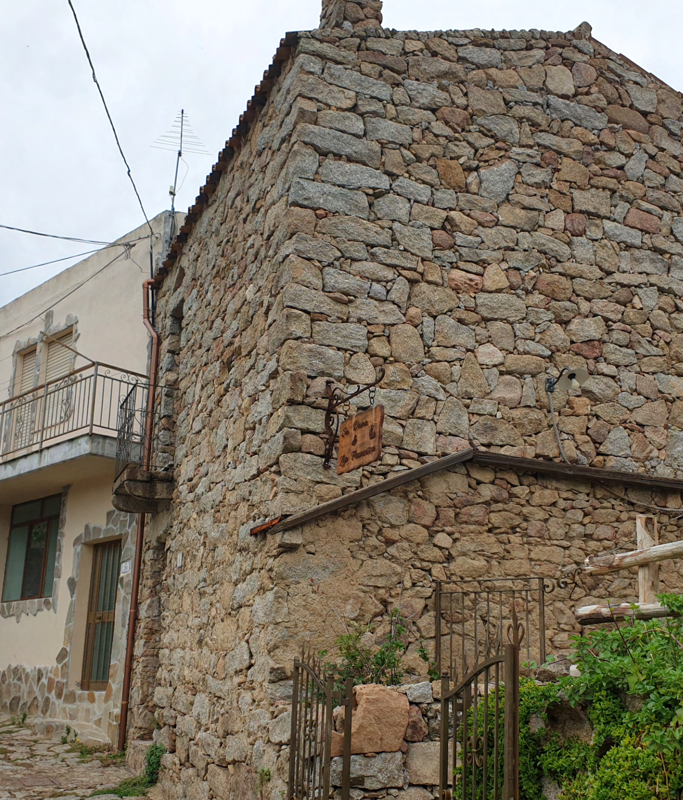
Figura 80 - Cantonali di un edificio di tipo unitario. (Foto dell'autore, 2021)
