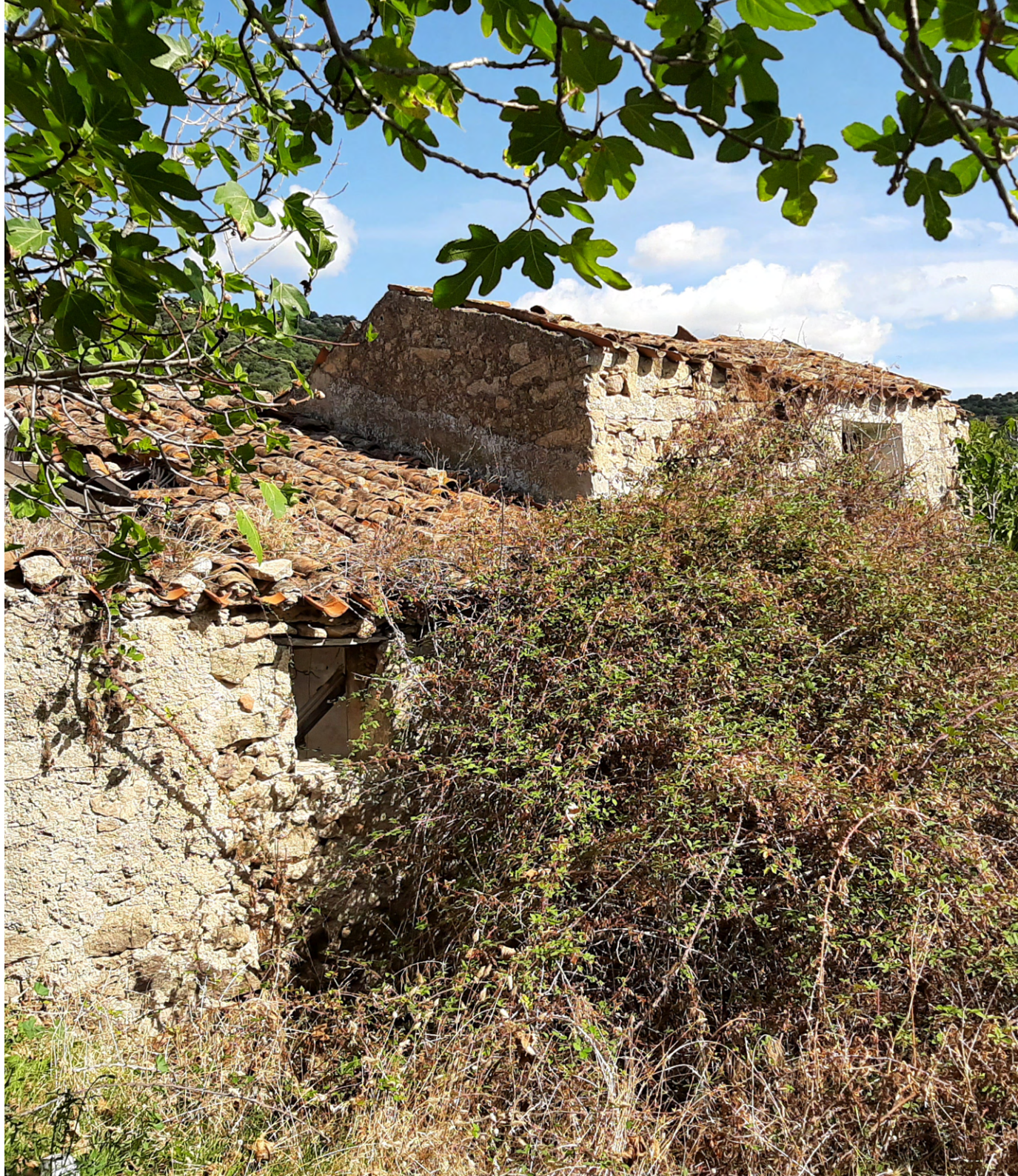
Figura 83- Gronda con coppi aggettanti (Foto dell'autore, 2021)
