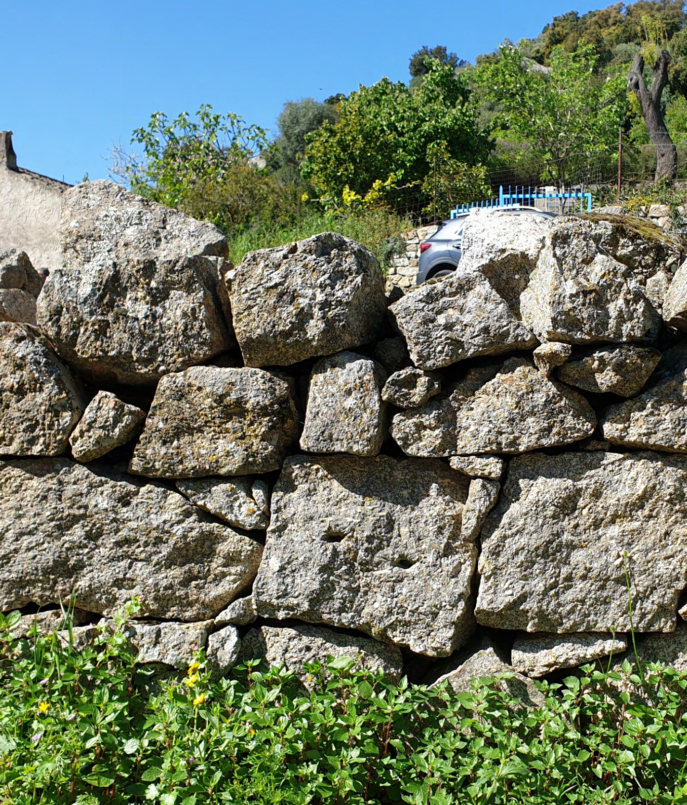
Figura 71 - Recinto realizzato con muratura di tipo Ms (Foto dell'autore, 2021)
