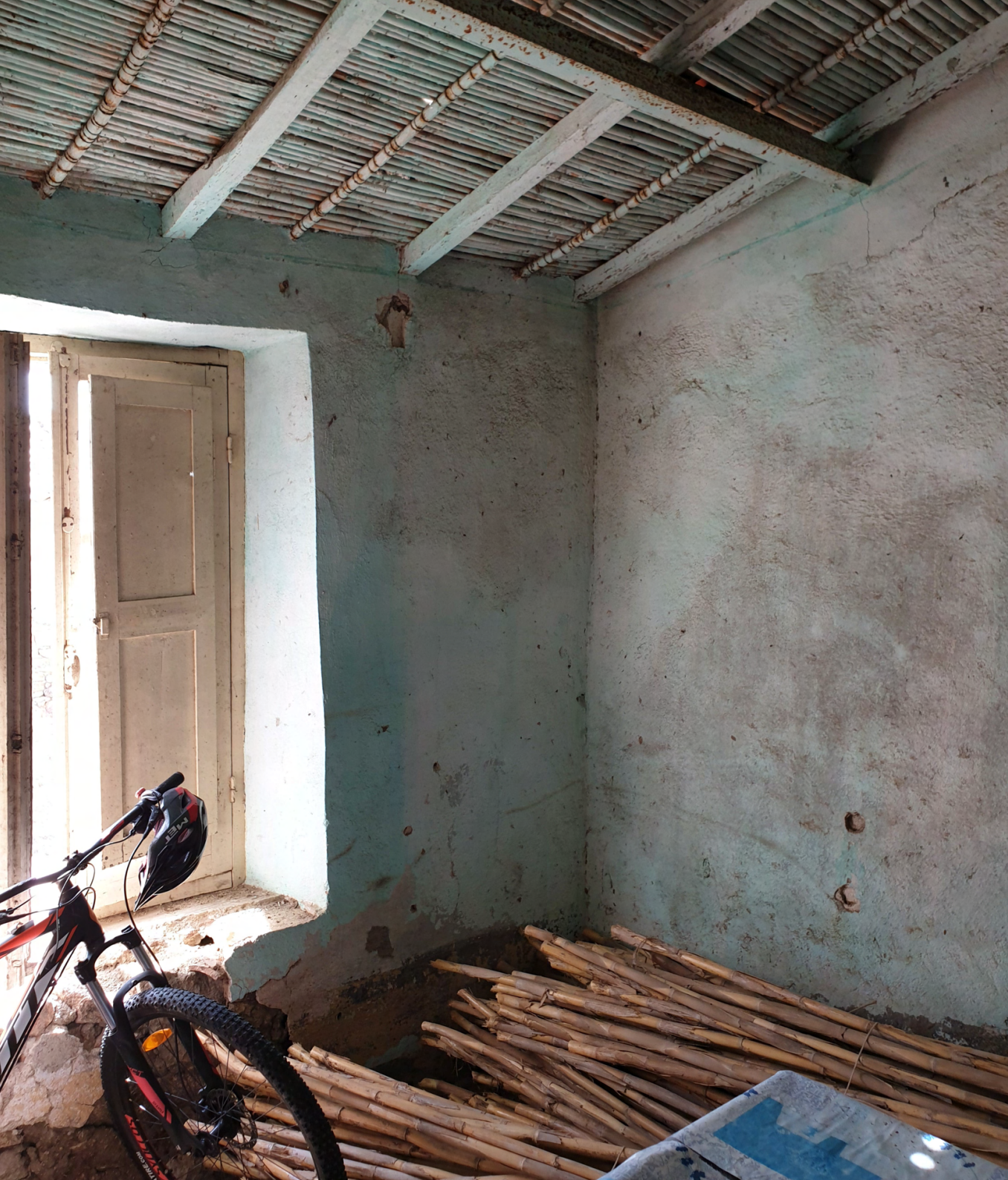
Figura 117 - Intonaco con finitura di pittura a secco nella prima cellula elementare.
