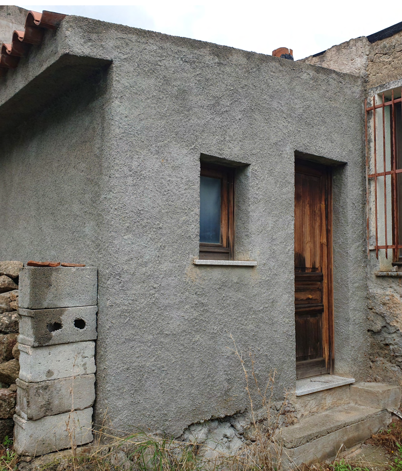
Figura 96 - Corpo aggiunto in blocchetti di cemento (Foto dell'autore, 2021)
