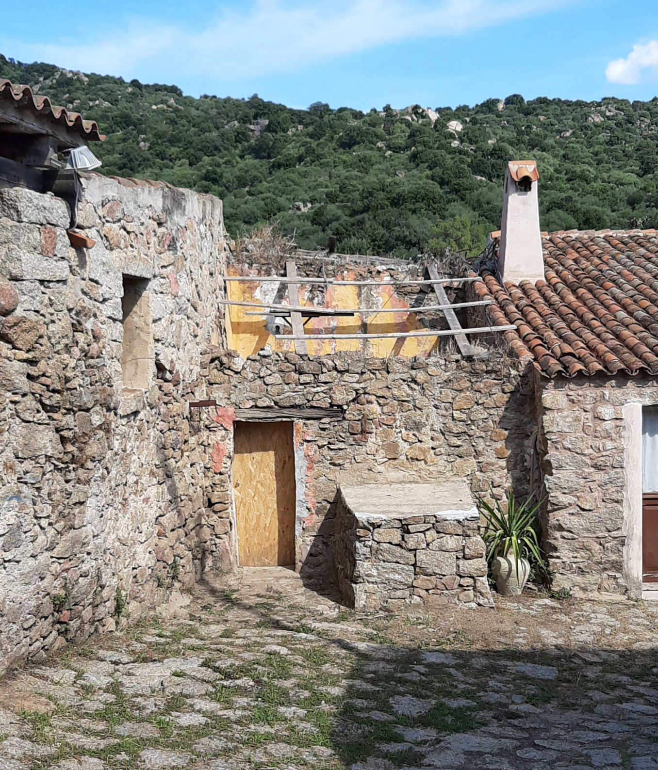
Figura 82 - Cellula elementare con copertura assente. (Foto dell'autore, 2021)
