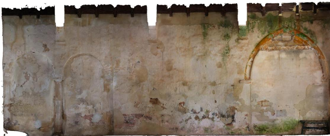
*Fig. 3.4 Ortofoto del prospetto interno nord della chiesa in cui sono state eliminate le colonne delle navate con il comando Selezione, al fine di ottenere una visione unitaria.*
