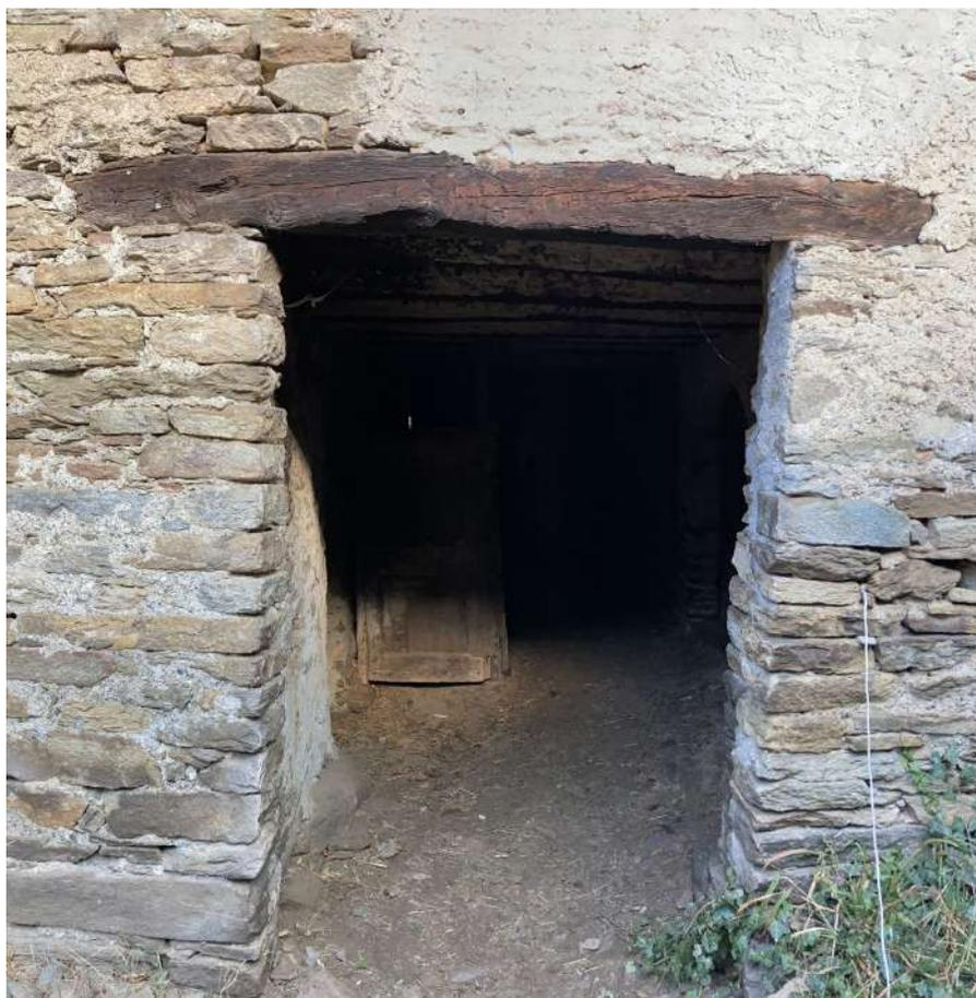
fig. 30. Foto esemplificativa di un varco di grandi dimensioni senza serramento individuato come modello "tipo", edificio 011. La foto mostra uno de varchi caratteristici che consente l'attraversamento della manica Sud della borgata.
