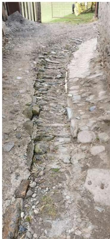
Fig. 7. Porzione della strada principale caratterizzata da un sistema di drenaggio delle acque. La foto mostra una parte della strada principale costituita da quel che resta di un antico sistema di scolo. Situata in una delle porzioni di strada più pendenti nella borgata nei pressi della scuoletta Beckwith.
