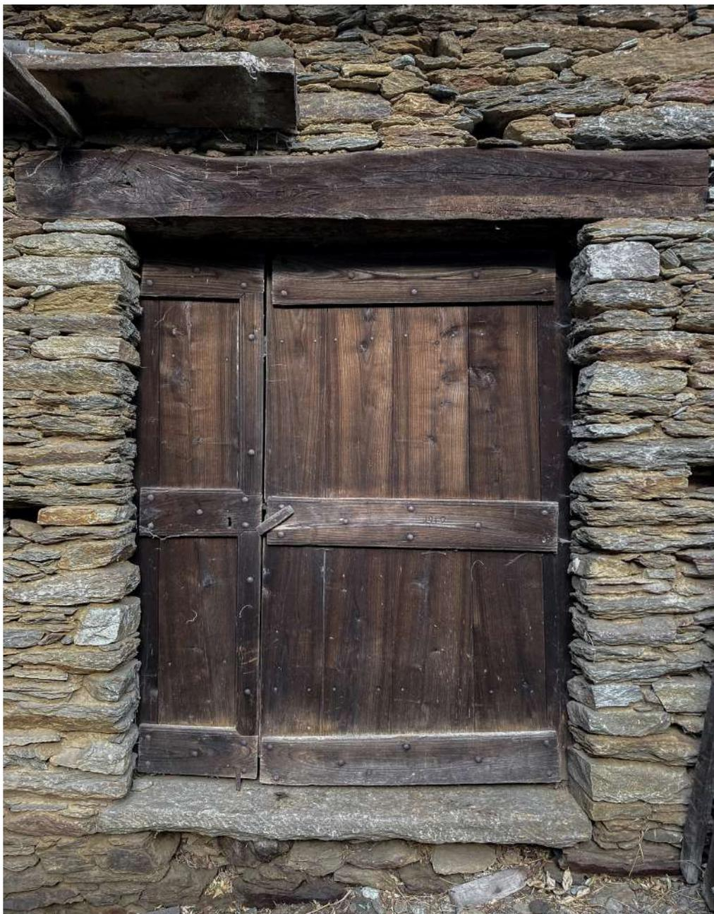
fig. 23. Foto esemplificativa del portone in legno a doppia anta individuata come modello "tipo", edificio 027. La foto mostra un portone in legno tradizionale a doppia anta asimmetrica, con assi verticali ed orizzontali inchiodati, dotato di un elemento di chiusura mobile in legno e caratterizzato da un architrave ligneo in sommità.
