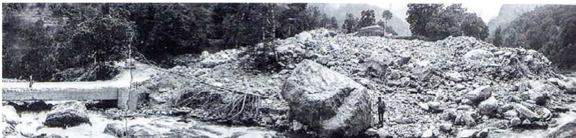
Fig. 12. Maggio 1977, accumulo detritico alla confluenza del Rio Imeut nel Pellice e distruzione della strada per Bobbio Pellice. 26.09.1920, Bobbio Pellice (TO)
