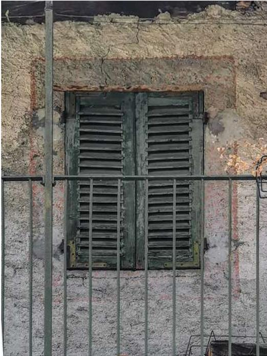
fig. 42. Foto esemplificativa dello scuro in legno a doppia anta individuato come modello "tipo", edificio 01.
