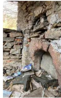
Fig.48. Forno appartenente all'edificio 026. Tipico forno in pietra ricavato sulla facciata dell'edificio.
