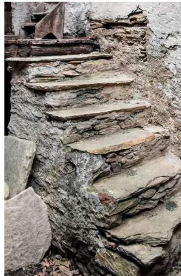
Fig. 39. Esempio di scala in pietra. L'immagine mostra una scala in pietra in parte rivestita da intonaco grezzo, permette l'accesso al piano primo dell'edificio 06.
