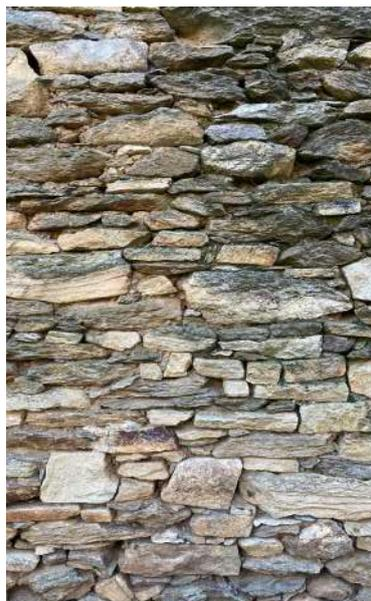
Fig. 14. Esempio di muro costituito da pietre locali a vista
