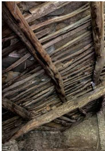
Fig. 28. Esempio di orditura lignea. L'immagine mostra la struttura portante di del tetto appartenente all'edificio 030 vista dall'interno.
