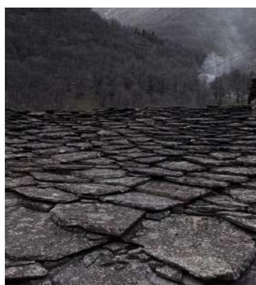
Fig. 27. Manto di copertura costituito da lose irregolari a pacco naturale tuito da pietre locali a vista
