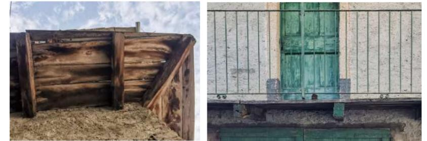
fig. 11. Dettaglio del tavolato ligneo appartenente al ballatoio dell'edificio 01.
