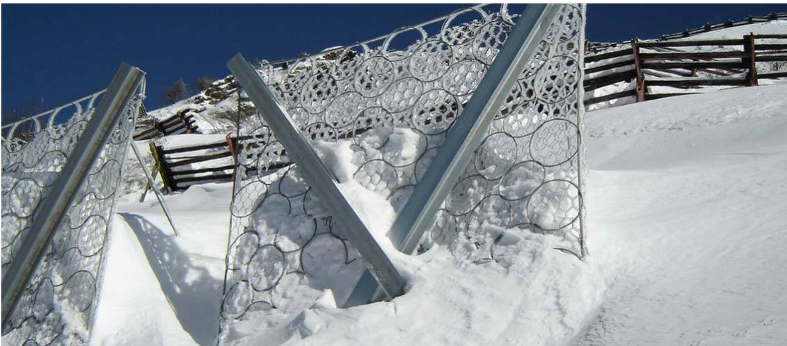
*Figura C2.19 Barriera mono-ancoraggio "VELA-Fermaneve"- fonte: geoprotection.com*
